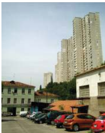
Fotografije postojećeg stanja
