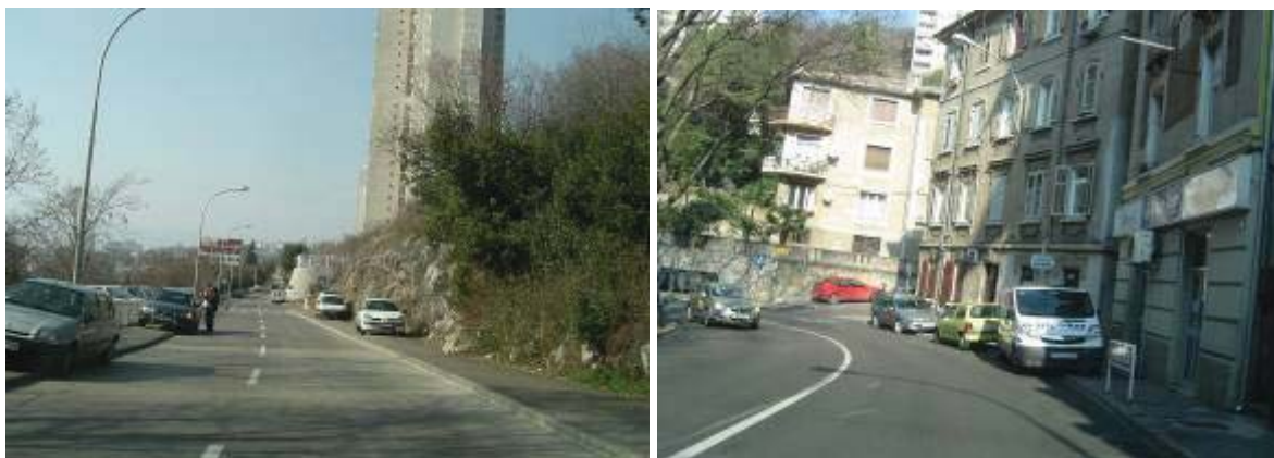
Fotografije postojećeg stanja
