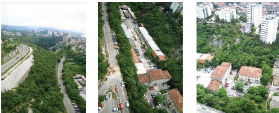
Fotografije postojećeg stanja
