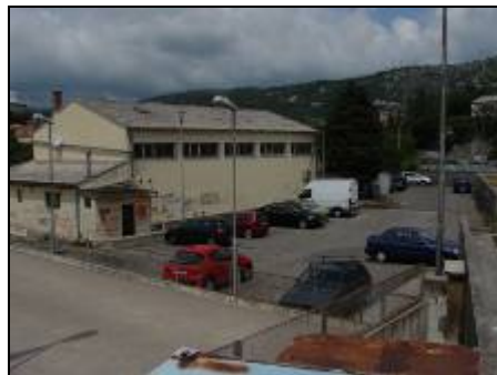
Pogled na jugoistočno pročelje Hrvatskog doma i postojeće parkiralište
