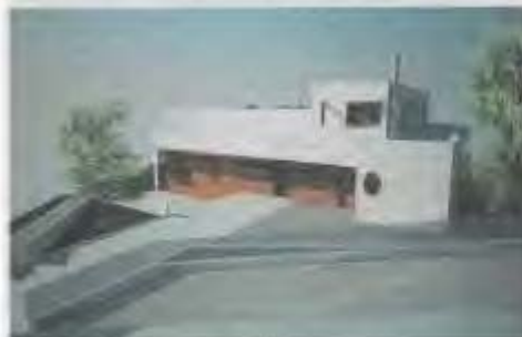
Novi vrtić na Pehlinu u fazi je izgradnje lokacije dječje
