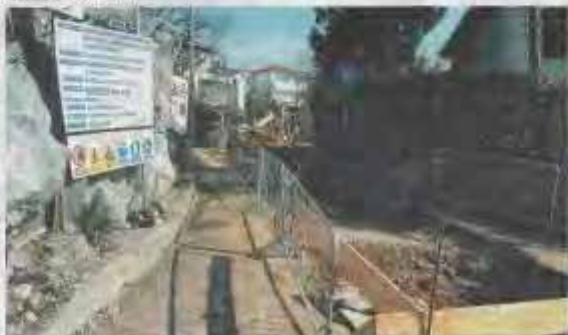
Stari put - čitavi poslovi, a i tamo je priprema za radove
