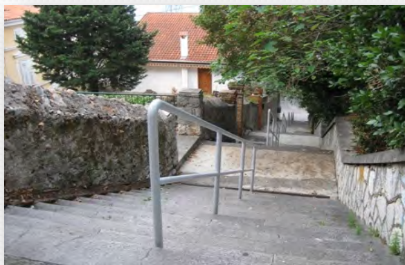
Postavljeni novi rukohvat na Gimnazijskim stubama
