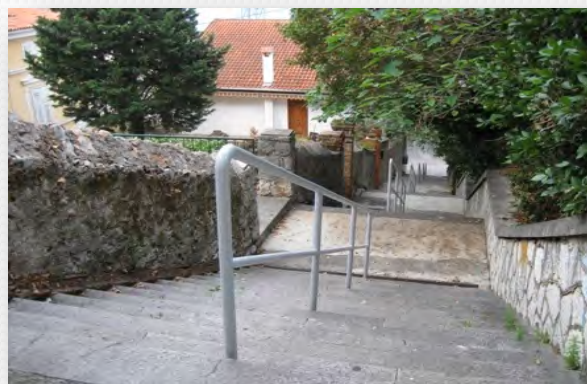
Postavljeni novi rukohvat na Gimnazijskim stubama
