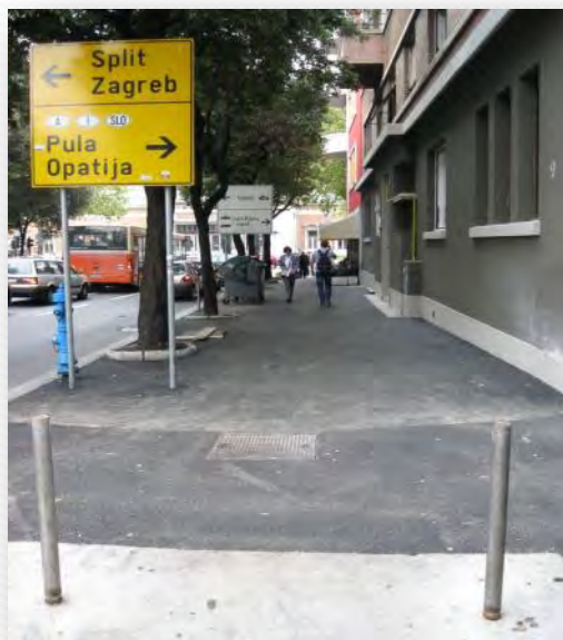
Asfaltiranje pločnika Nikole Tesle 1
