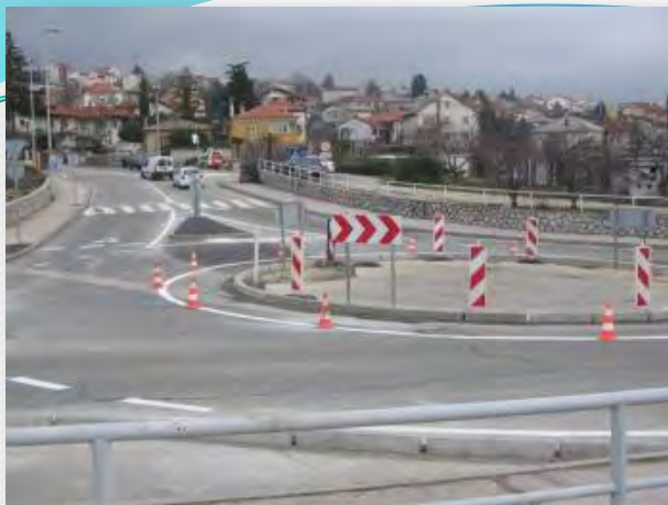
Izgradnja rotora u Primorskoj ulici/Vladoj i Milivoja Lenca
