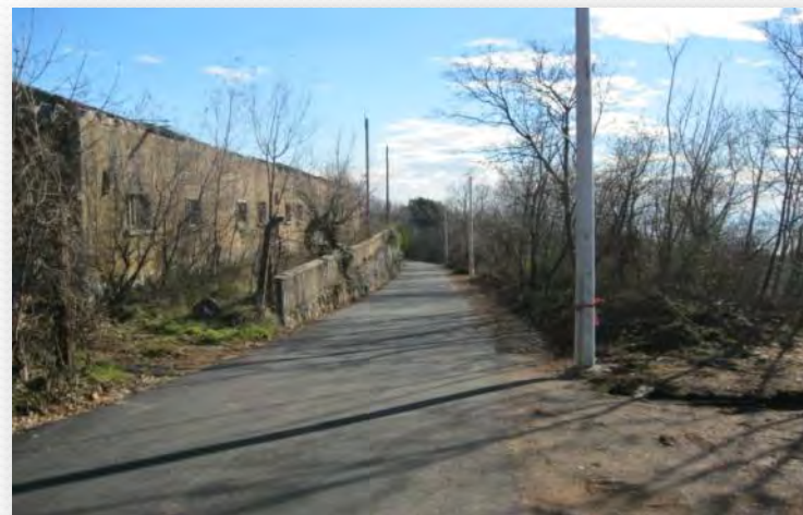
Asfaltiranje spoja Ulice Pulac prema Svetoj Katarini i postavljanje rasvjetnih stupova
