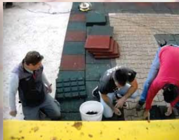
priprema podloge i montaža tlakovaca, postavljanje gumenih podloga
