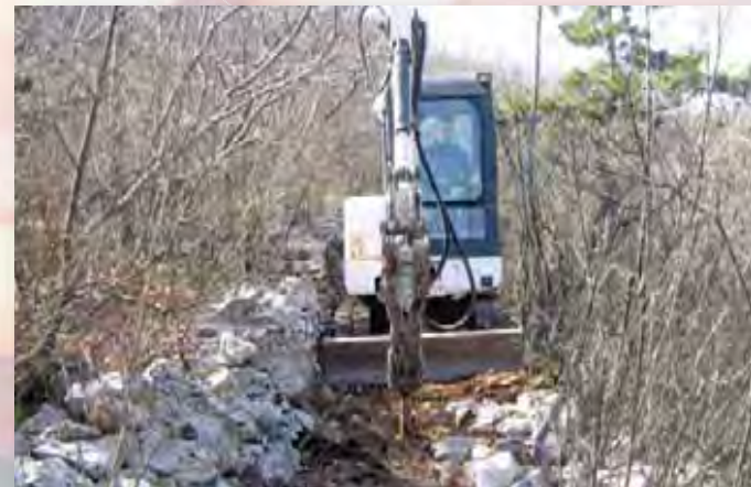
Strojni iskop i krčenje terena buduće pješačke staze
