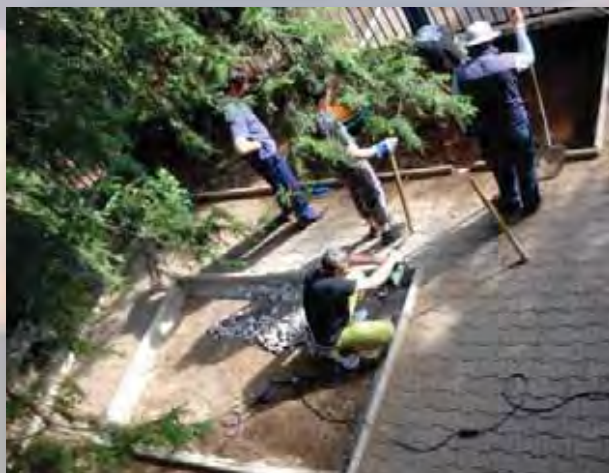
priprema podloge i montaža tlakovaca, postavljanje gumenih podloga
