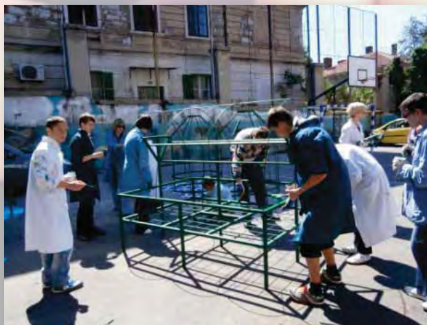
bojanje metalnih konstrukcija vrtnih slagalica
