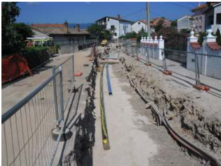
Slika 11: Izgradnja plinovoda na području Grada Rijeke – ul. Milice Jadranić
