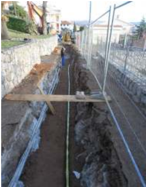
Slika 13: Izgradnja plinovoda na području Grada Opatije - naselje Pobri
