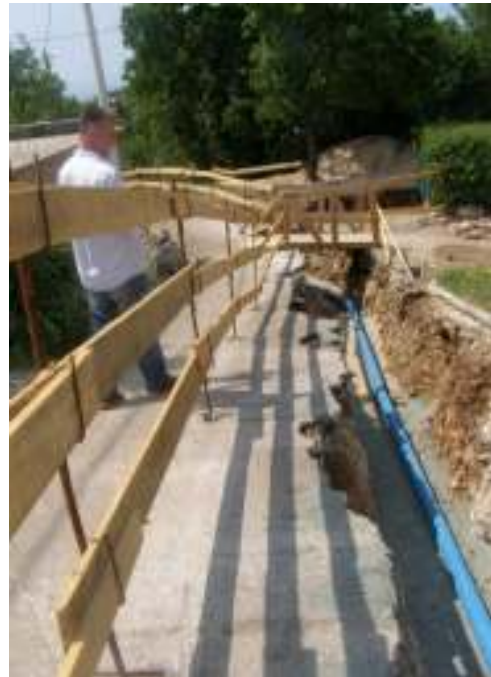
Slika 9: Izgradnja vodovodnog ogranaka na području Rijeke
