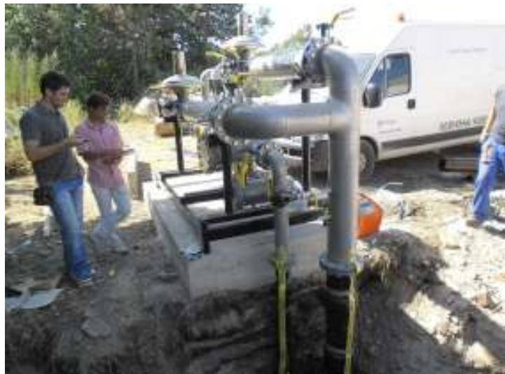
Slika 14: Postavljanje plinske redukcijske stanice - asfaltna baza Marišćina
