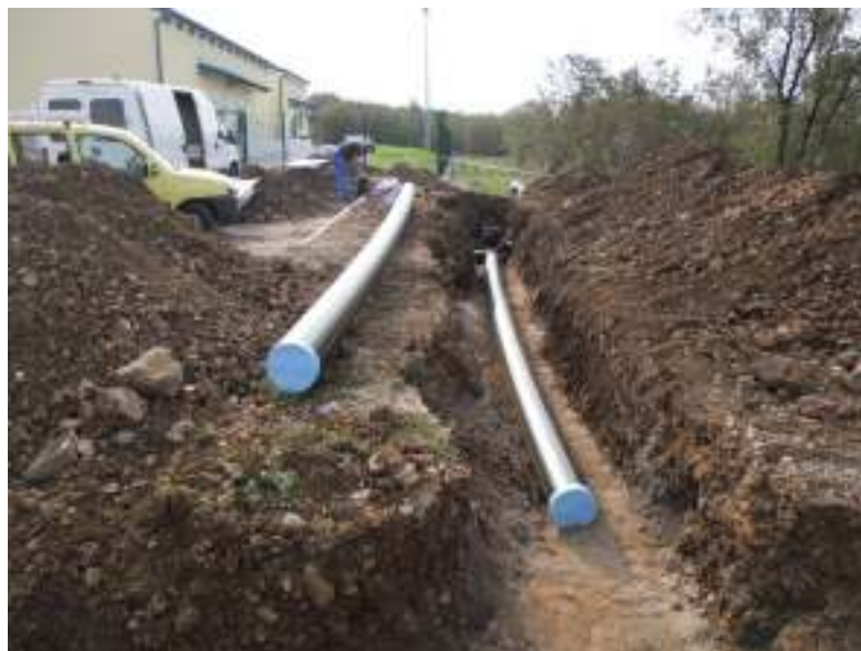
Slika 12: Izgradnja plinovoda na području Grada Bakara - Industrijska zona Kukuljanovo
