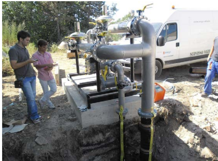
Slika 14: Postavljanje plinske reduksijske stanice - asfaltna baza Marišćina
