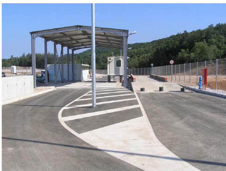
Slika 7: Ulaz u privremeno odlagalište ŽCGO Marišćina
