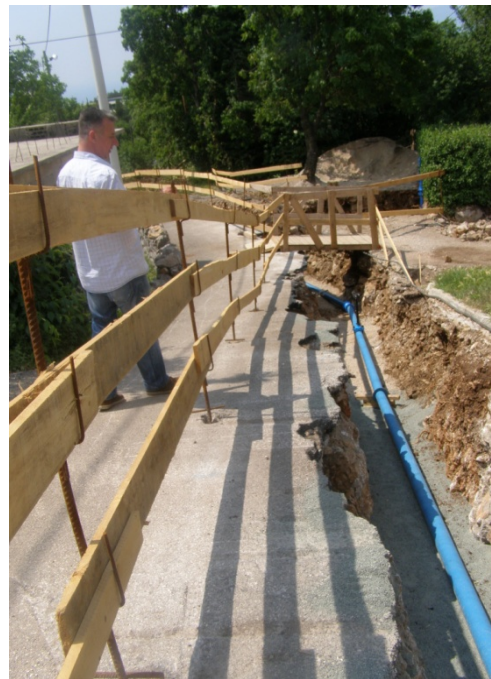
Slika 9: Izgradnja vodovodnog ogranaka na području Rijeke
