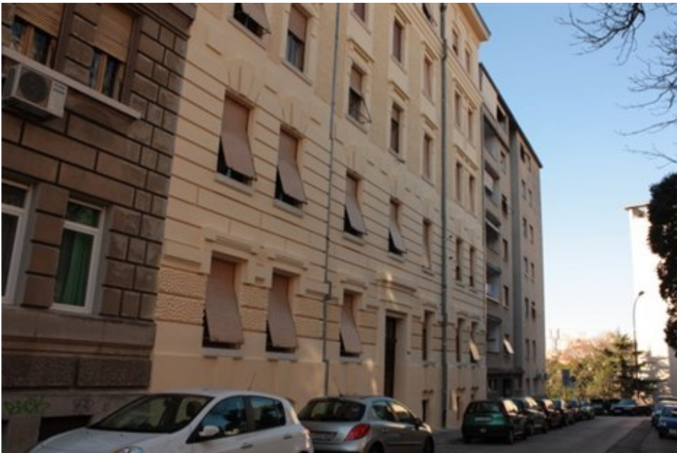
Ljudevita Matešića 17- dovršeni su radovi sanacije i obnove koje je Grad Rijeka sufinancirao u iznosu od 117.674,10 kn.
