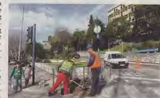
Radovi u Krešimirovoj ulici
