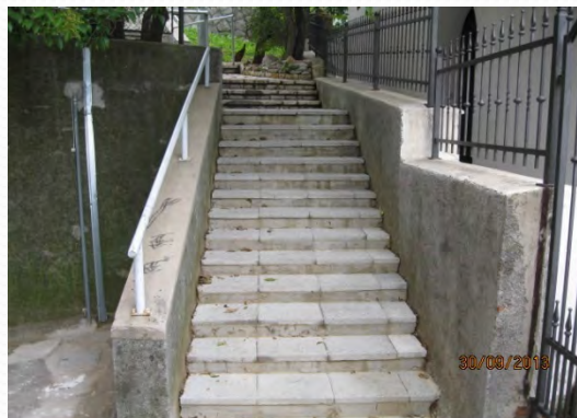
Sanacija stubišta Kumičićeva 41a
