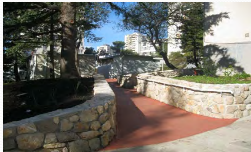
Rampa za invalide i dječja kolica Drage Gervaisa
