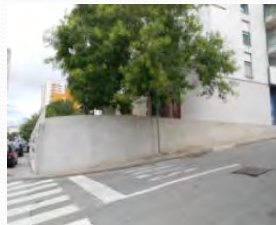
Saniran potporni zid u ulici Franje Čandeka
