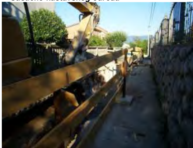
Slika 13: Radovi na vodovodu i kanalizaciji u Sušačko-kastavskog odreda
