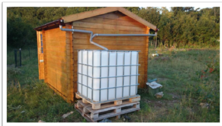
Slika 3. Uređenje alatnice i cisterne za skupljanje kišnice
