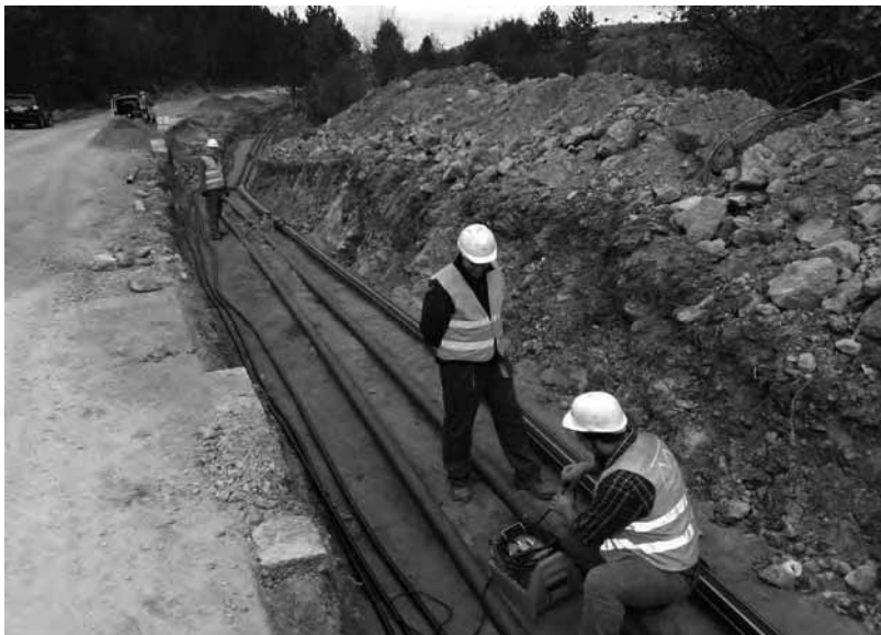
Slika 21: Rekonstrukcija plinovoda na državnoj cesti D427 - odvojak za Studenu
