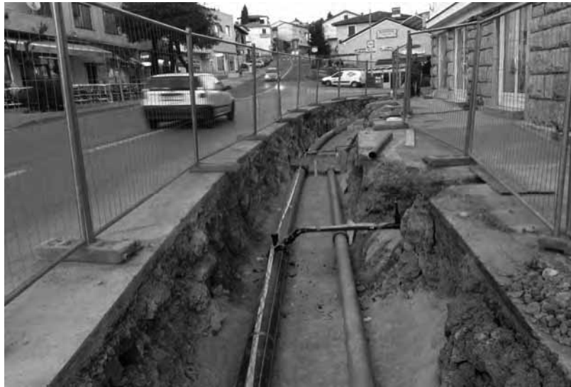
Slika 20: Izgradnja plinovoda na području Općine Matulji - Trg maršala Tita
