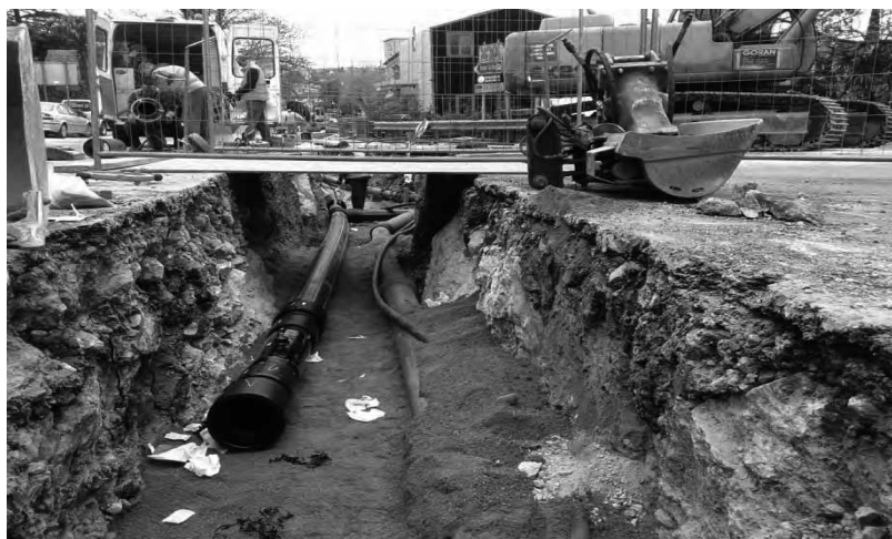
Slika 19: Izgradnja plinovoda na području Općine Matulji - Cesta dalmatinskih brigada
