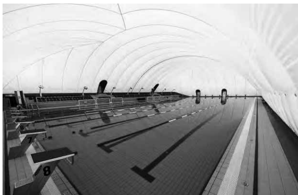
Slika 1: Novi presostatski balon, Bazeni Kantrida
