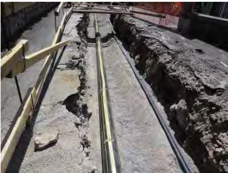
Slika 29: Izgradnja plinovoda na području Grada Rijeke – ul. Milice Jadranić - nastavak
