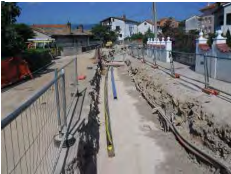
Slika 28: Izgradnja plinovoda na području Grada Rijeke – ul. Milice Jadranić - nastavak
