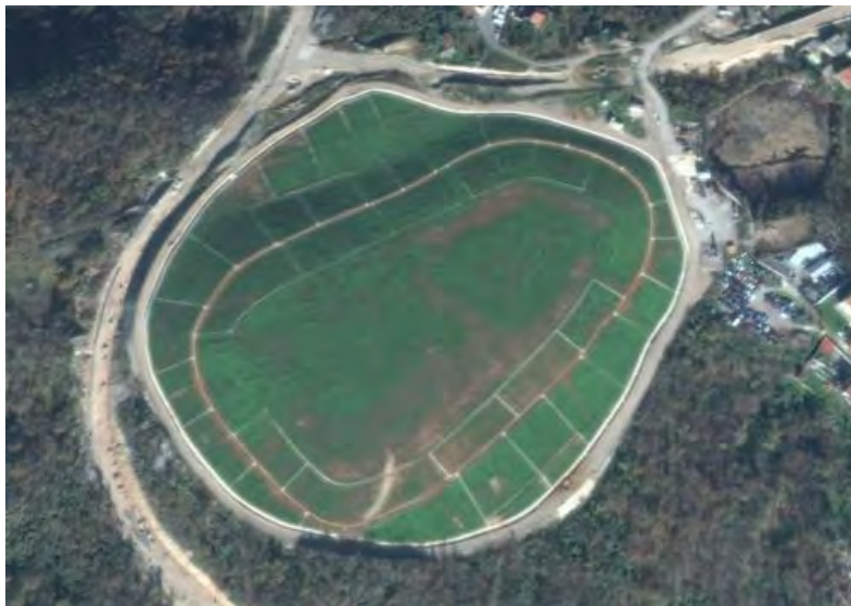
Slika 7: Sanirano odlagalište neopasnog otpada Viševac
