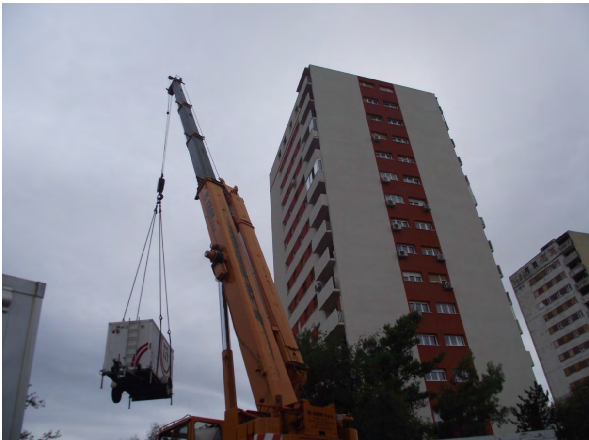
Slika 22: Montaža mobilnih kotlovnica u naselju Vojak
