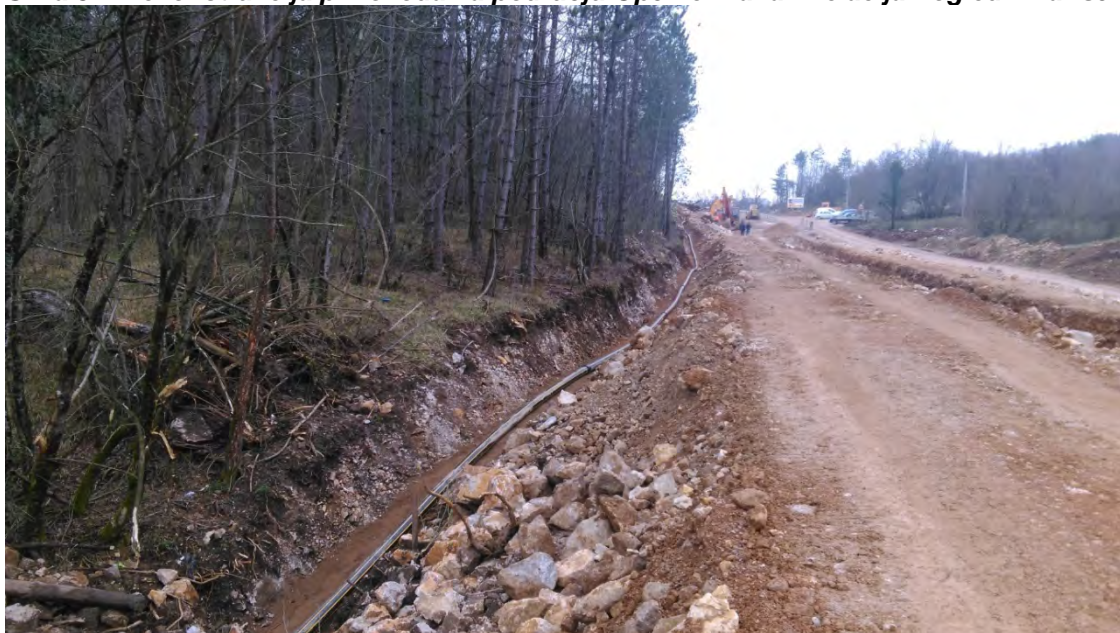
Slika 34: Rekonstrukcija plinovoda na području Općine Klana – relacija Pogled - Marišćina
