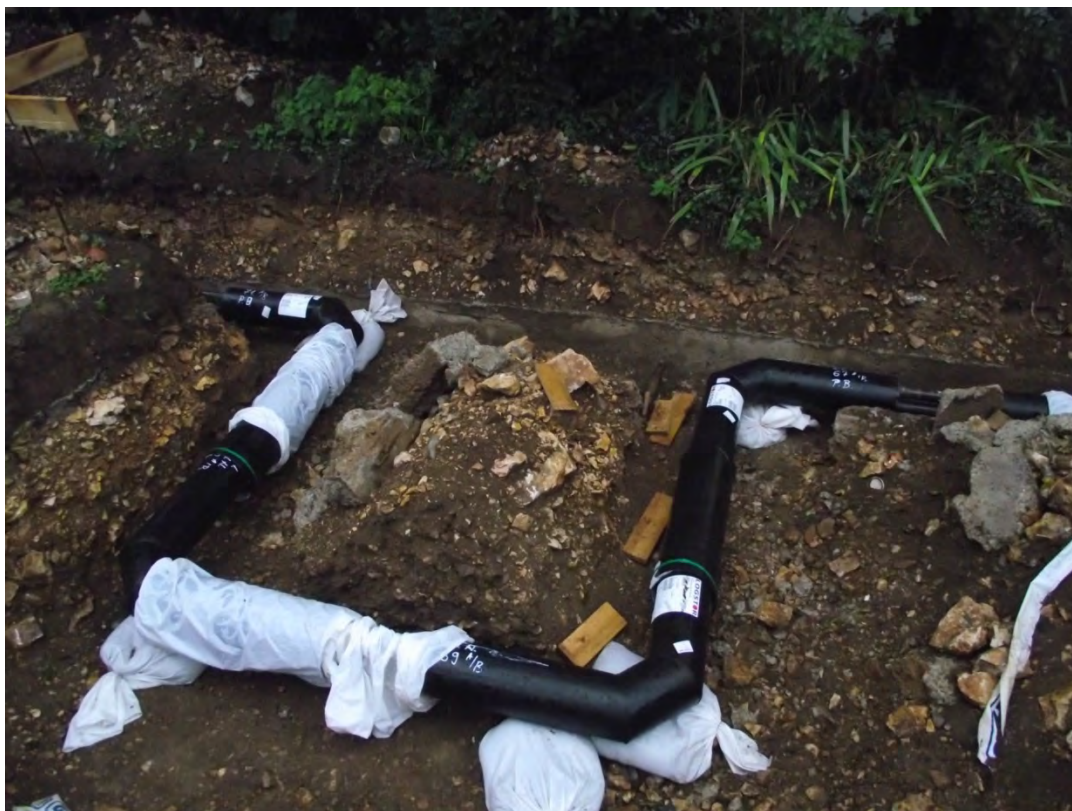
Slika 24: Spajanje sustava wet – detection
