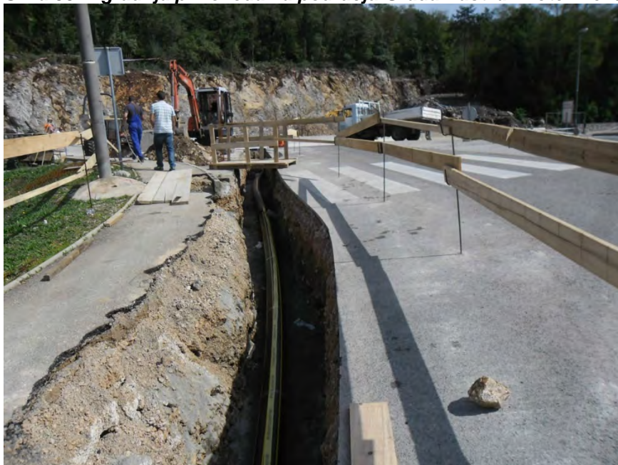
Slika 33: Izgradnja plinovoda na području Grada Kastva – rotor Belići
