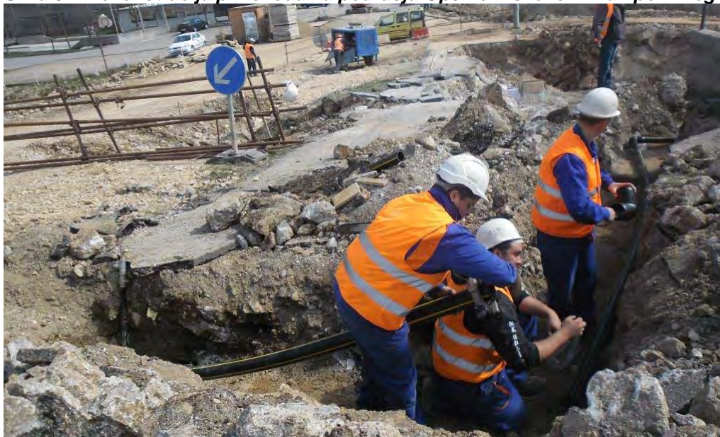
Slika 32: Rekonstrukcija plinovoda na području Općine Viškovo – Trampov Breg
