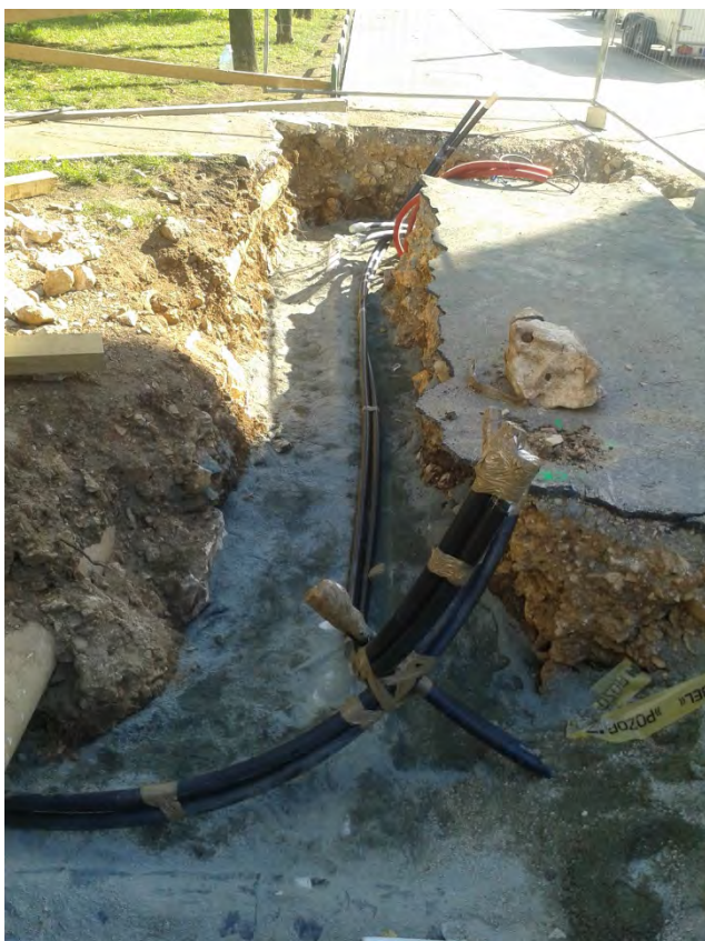
Slika 27: Kabelski zdenac optike prije zatrpavanja
