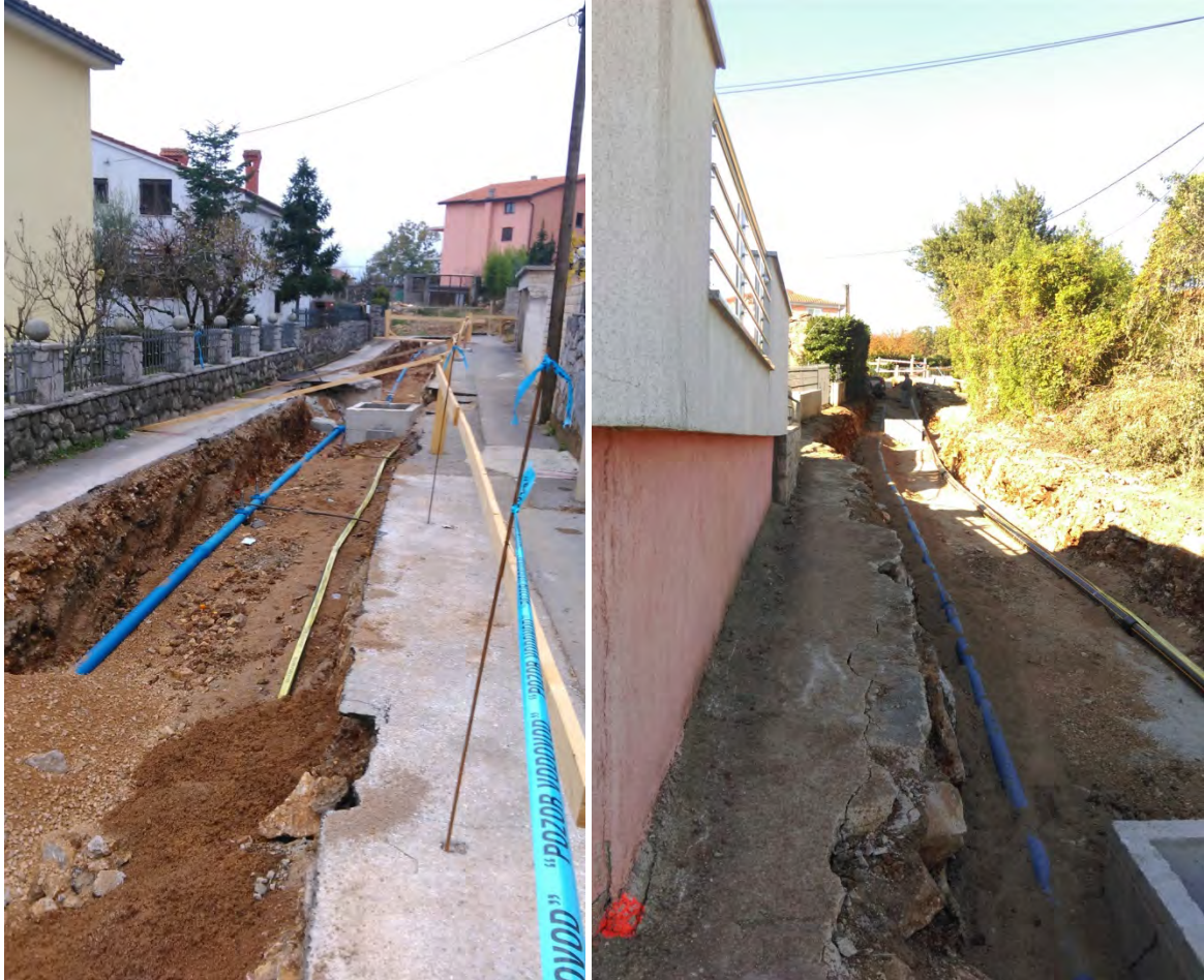
Slika 28: Izgradnja plinovoda na području Grada Rijeka – Murini
