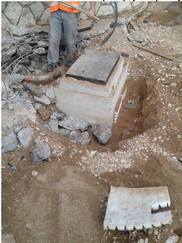
Slika 27: Kabelski zdenac optike prije zatrpavanja
