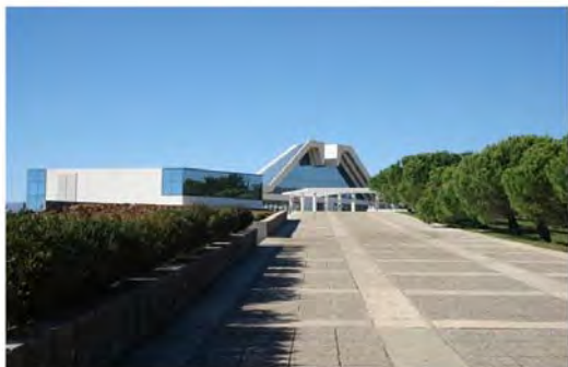
Slika 36: Centralni objekt na CGG Drenova
