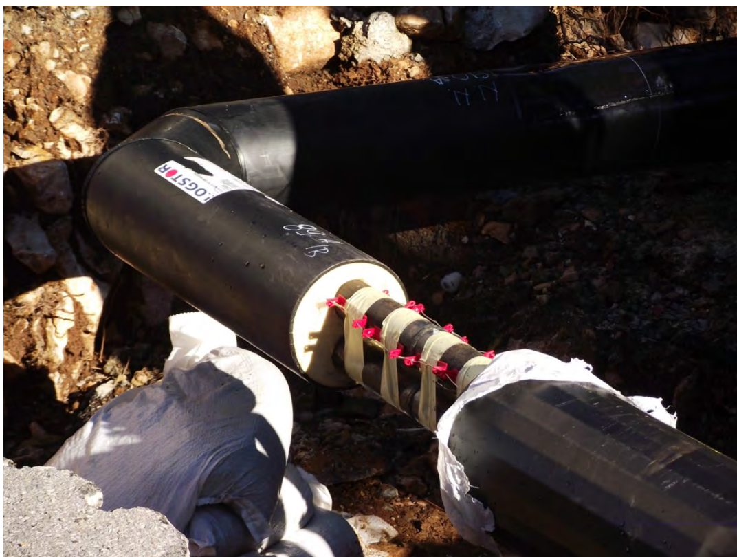
Slika 24: Spajanje sustava wet – detection
