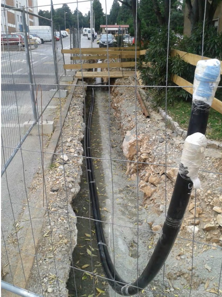
Slika 26: Točka grananja DTK prije uvlačenja PEHD cijevi u kablski zdenac
