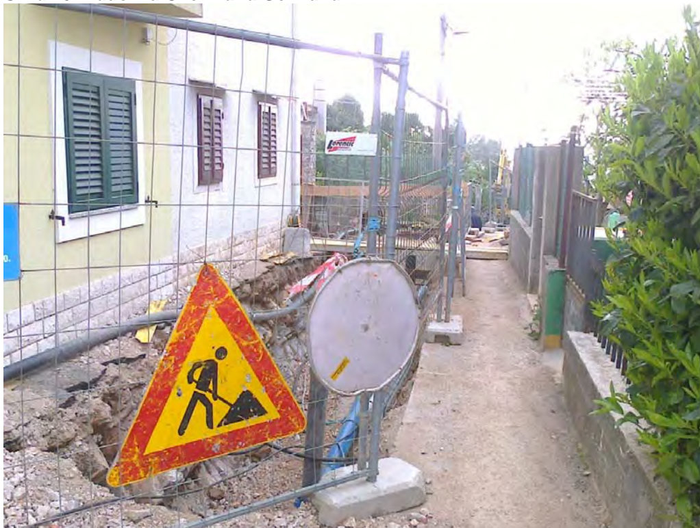
Slika 20: Radovi u Ulici Maria Gennaria
