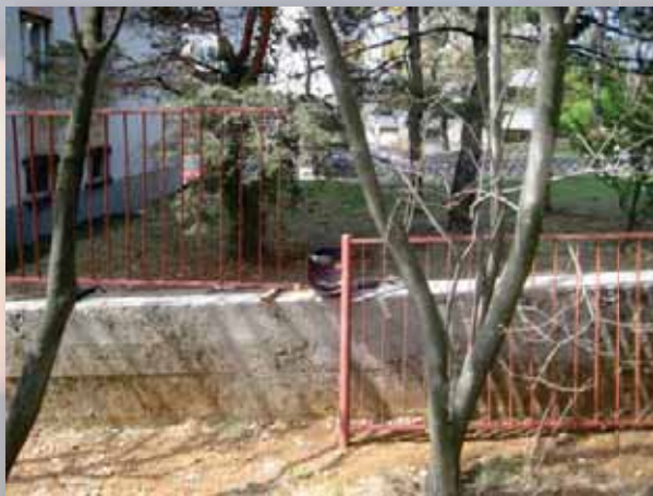
OGRADA VRTIĆA vraćanje iste nakon pjeskarenja, premazivanja temeljnom bojom, varenja, bojanje ograde
