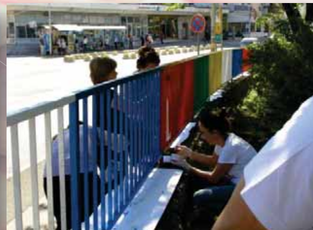
OGRADA VRTIĆA vraćanje iste nakon pjeskarenja, premazivanja temeljnom bojom, varenja, bojanje ograde
