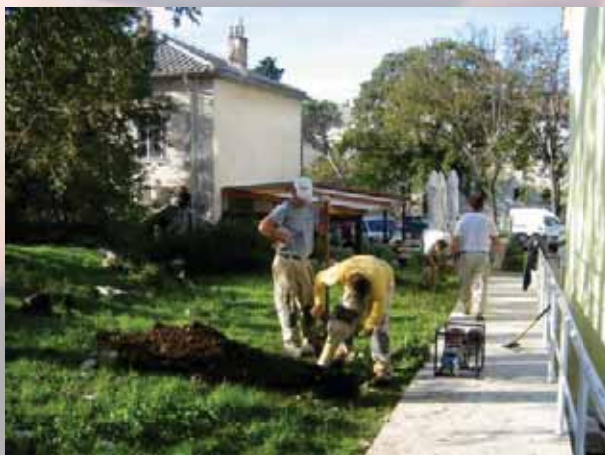
strojno ručni iskop rupa
