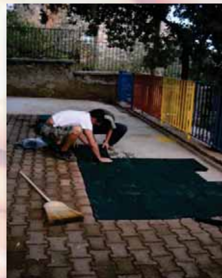
priprema podloge i montaža tlakovaca, postavljanje gumenih podloga
