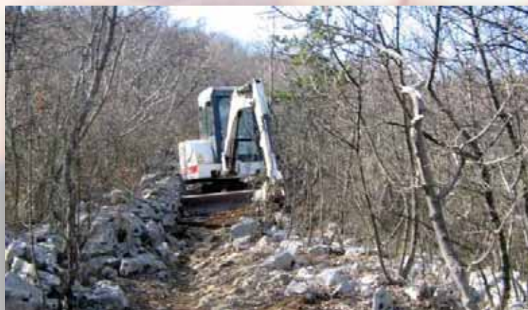
Strojni iskop i krčenje terena buduće pješačke staze
