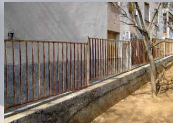
demontaža, montaža i pjeskarenje ograde na zapadnom zidu - 30m
