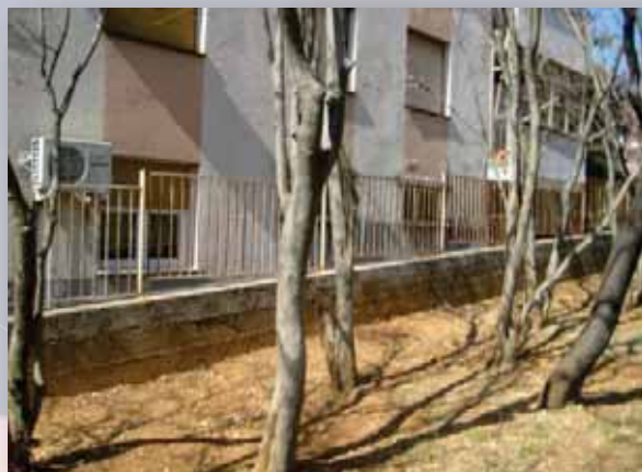
ograda vrtića prije radova
