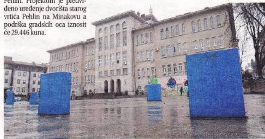
Betonska površina ispred škole bit će »ušminkana«
