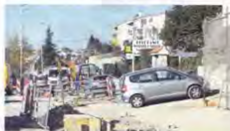
Raskopani kanali u Ulici Ivana Žorža
