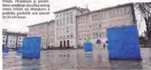
Radovi na uređenju školskog trga iznad garaže na Minakovu.
