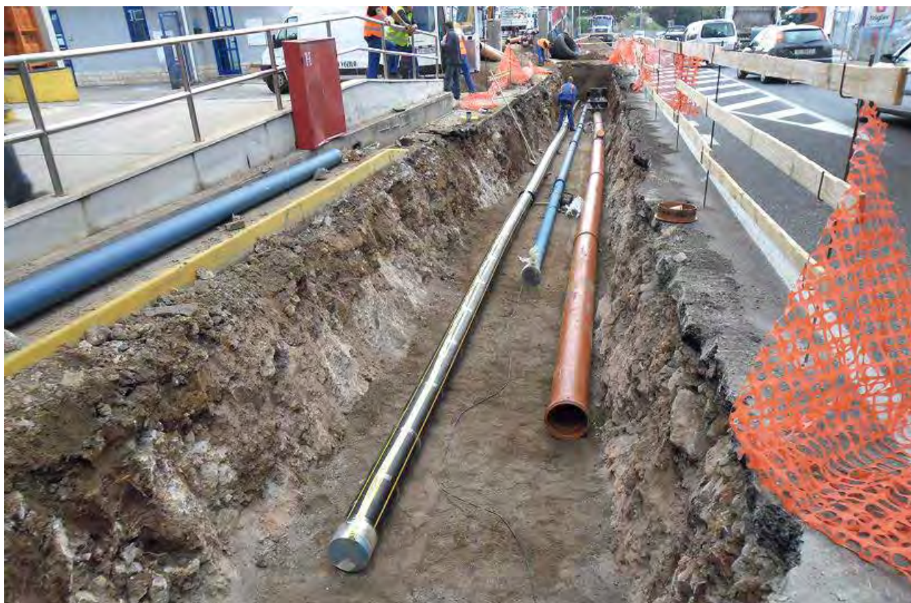
Energo – ugradnja plinske mreže.
