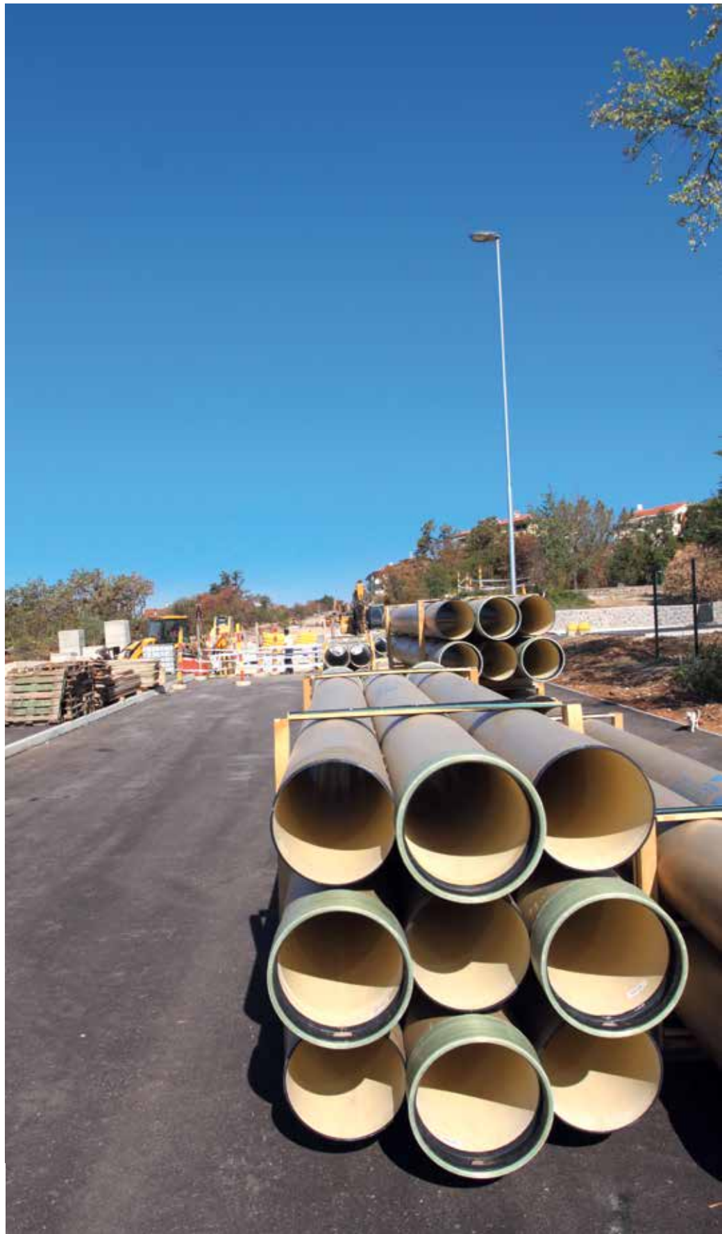
Cijevi za ugradnju u kolektor kanalizacije Ž5025
