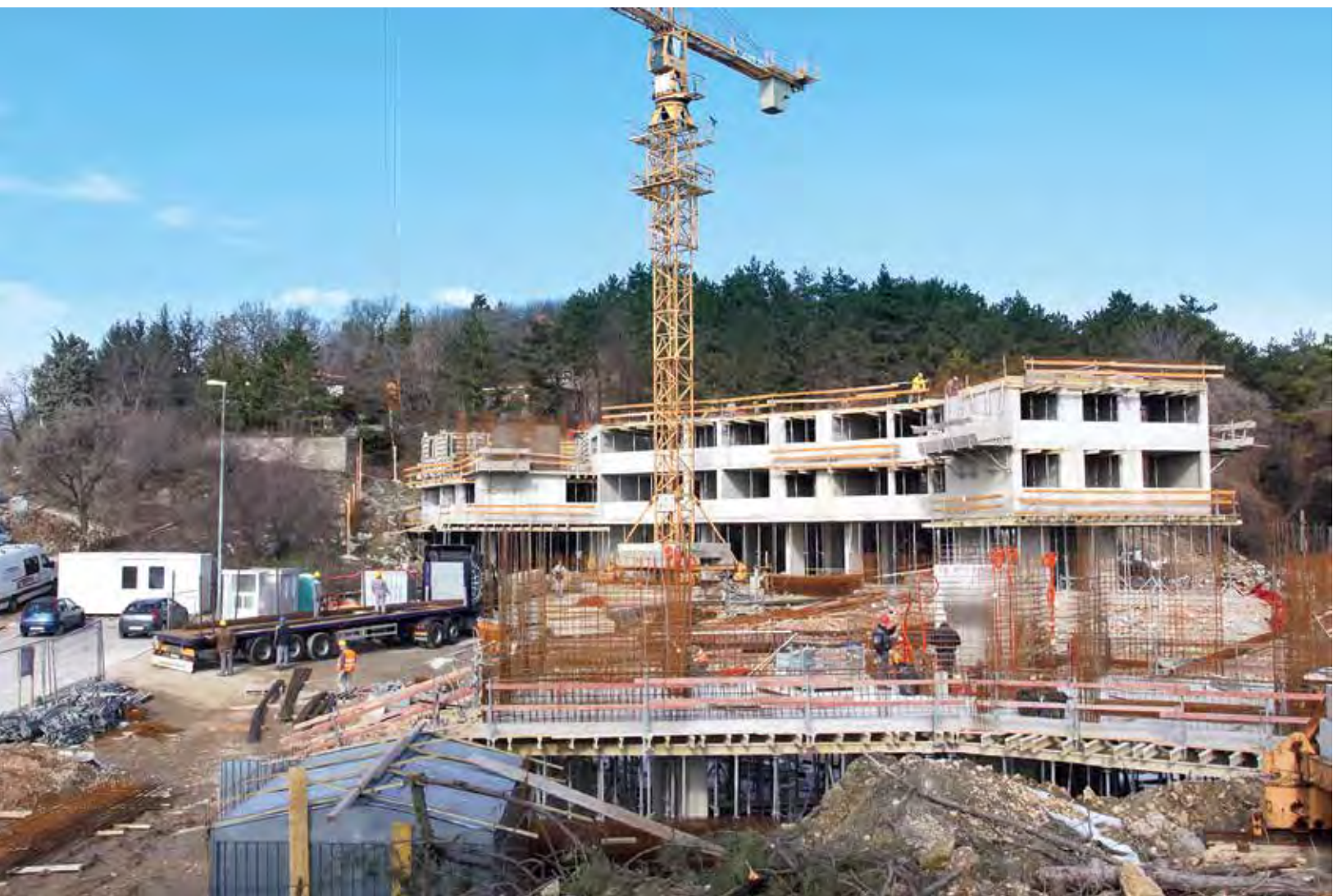
Izgradnja novih stanova prema programu POS-a na Donjoj Drenovi
