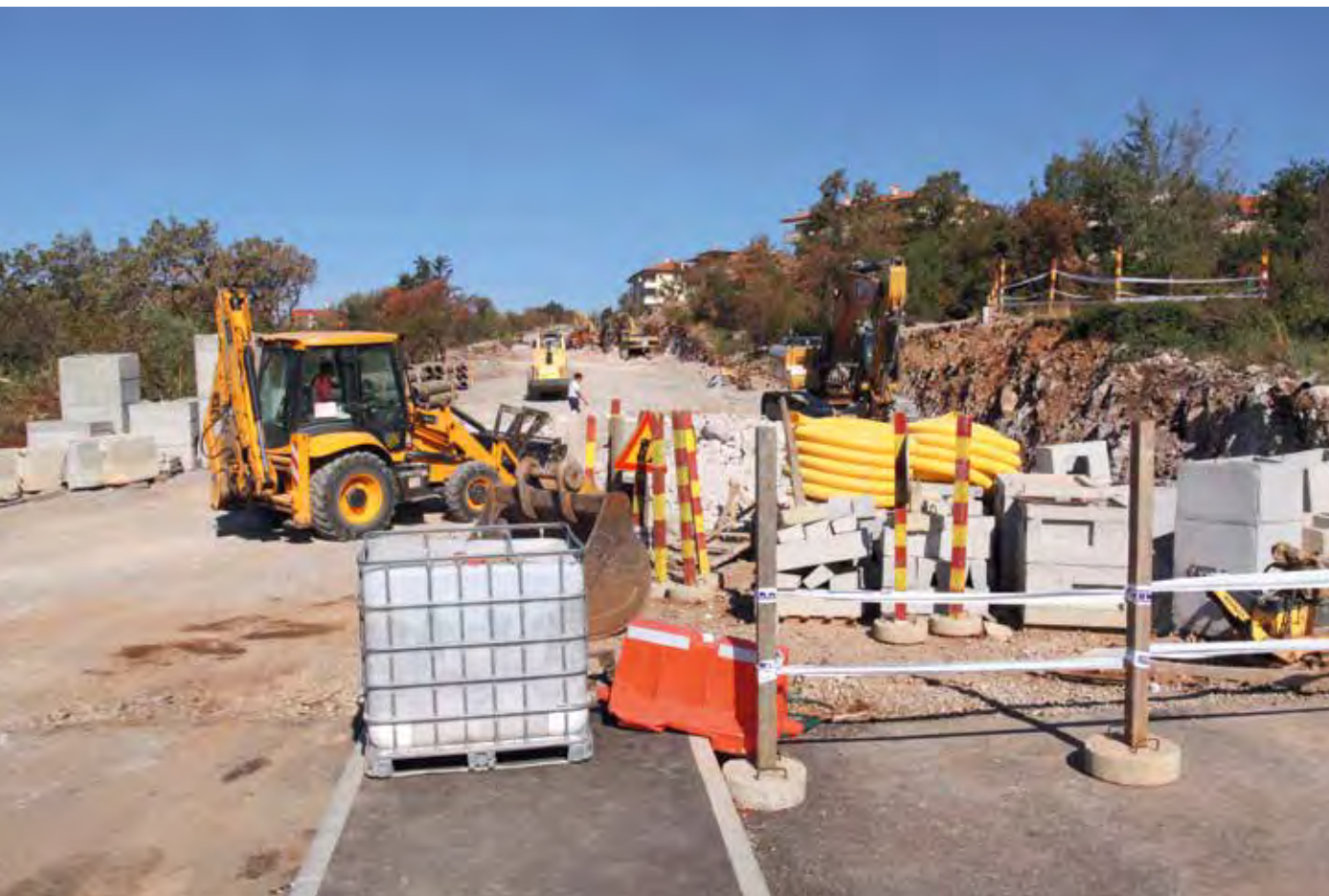
Gradilište zadnje dionice ceste Ž5025
