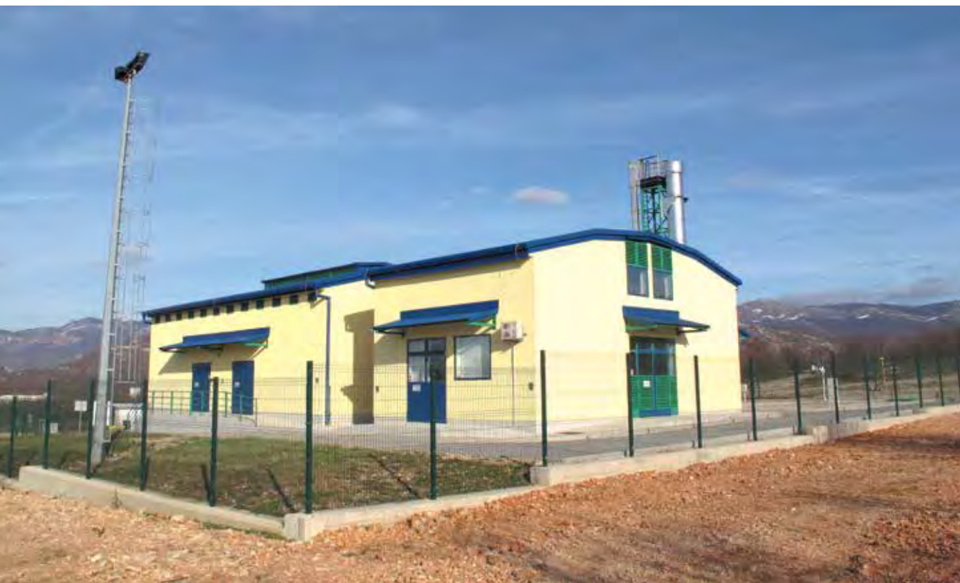
Kukuljanovo – odorizacijska i mjerno-redukcijska stanica Energa za područje Rijeka-Istok
