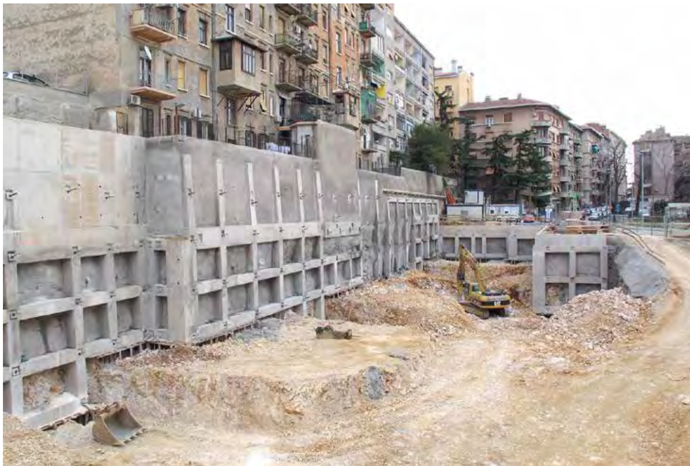
Izgradnja garaže Zagrad B
