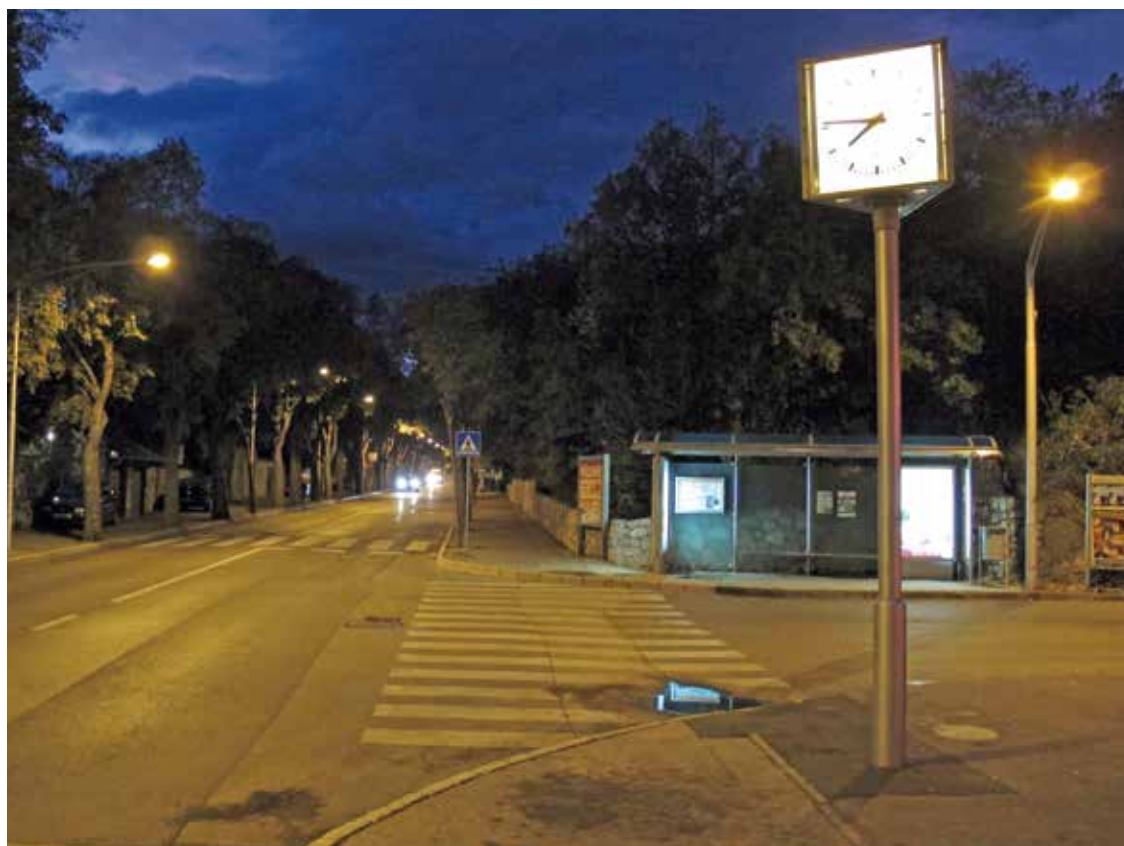
Ugradnja energetski učinkovite javna rasvjeta na području Bivia.
