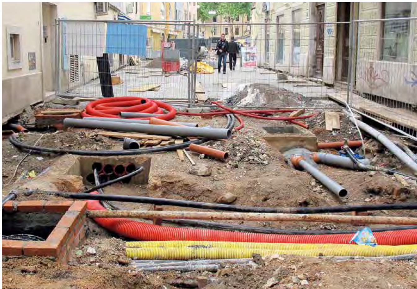
Ugradnja svjetlovodne komunikacijske infrastrukture u Vitezovićevoj ulici – centar Grada
