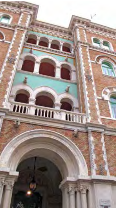
Obnova pročelja u sklopu liste prioriteta
