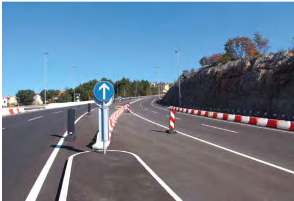
Detalji prometne signalizacije na cesti Ž5025
