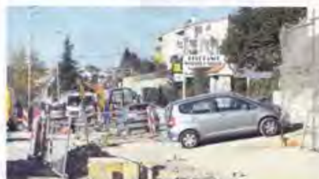
Raskopani kanali u Ulici Ivana Žorža
