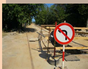
RADOVI U TIJEKU
