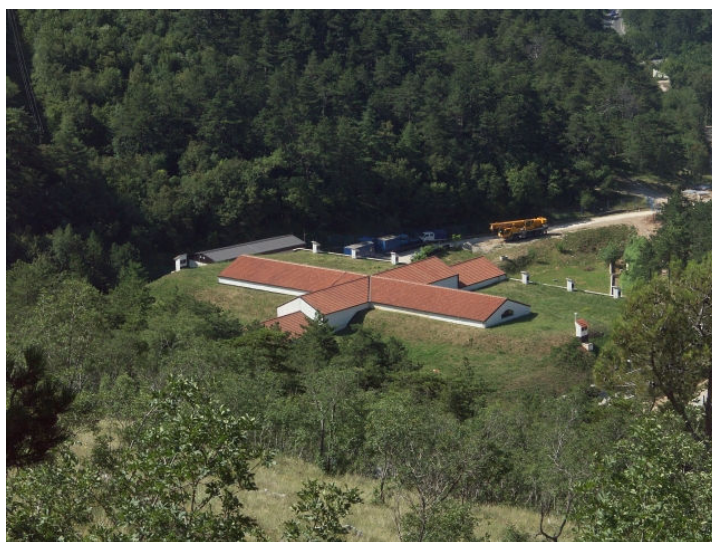
Vodosprema Streljana II
