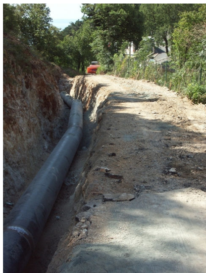
Izgradnja tlačnog cjevovoda
