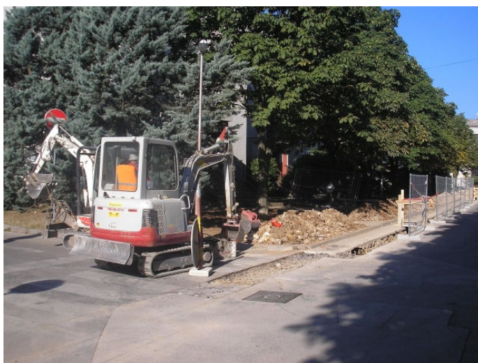
Radovi na plinifikaciji obavljani su ovoga ljeta
