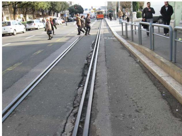
Oštećen kolnik ulice Ivana Zajca uz željezničke tračnice
