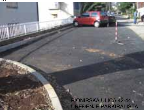
IZGRADNJA POTPORNOG ZIDA NA SKRETANJU IZ ISTARSKE ULICE NA PUT TURAN 4.
