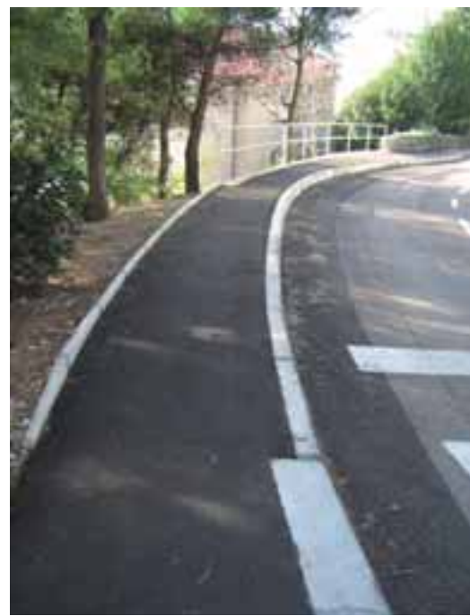
LOVRANSKA ULICA, UGRADNJA VODOLOVKI ZA RJEŠENJE OBORINSKE VODE
