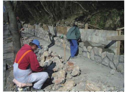
Izgradnja potpornog zida u istarskoj ulici
