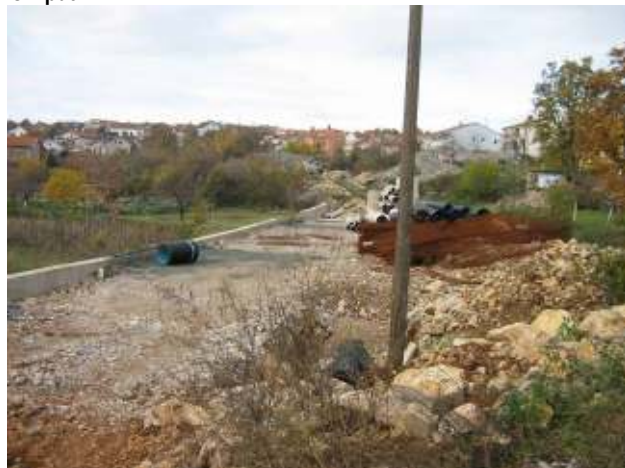
Izgradnja ceste 233 prema Kastvu
