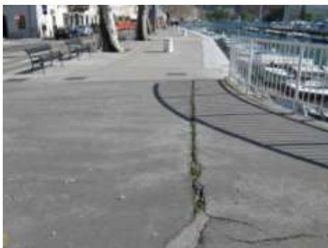
Sanaciju nogostupa uz Ribarsku ulicu na prilazu Mostu hrvatskih branitelja
