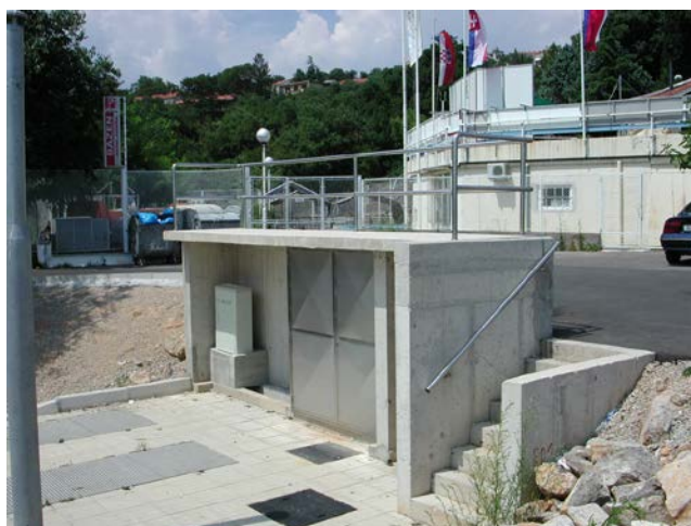
Prikaz 9.: Izgled nedavno izgrađene crpne stanice "Bazen" koja prikuplja kanalizaciju postojećeg bazenskog kompleksa.
