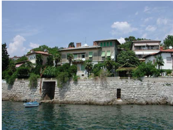
Prikaz 7.: Izgled kamenog obalnog zida iznad kojeg je izgrađena grupa obiteljskih kuća sjeverno od granice obuhvata uz ulicu Portić.
