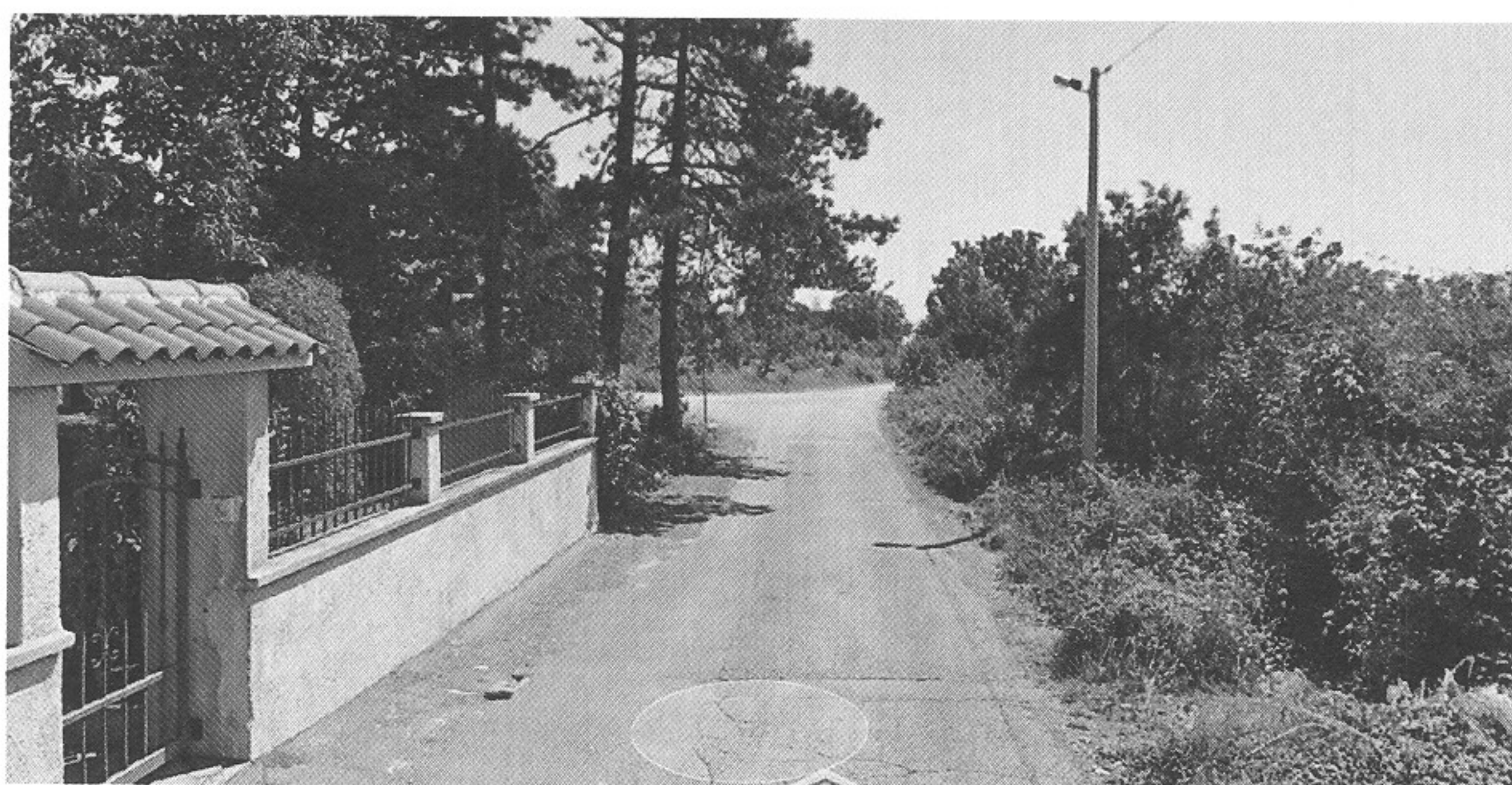
Slika 2 – ulica Čavalsko, postojeće stanje
