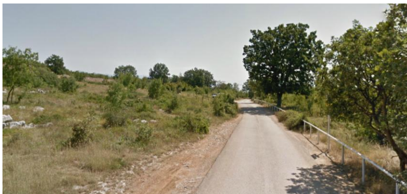
Slika 3 – ulica Marko Gennari, postojeće stanje
