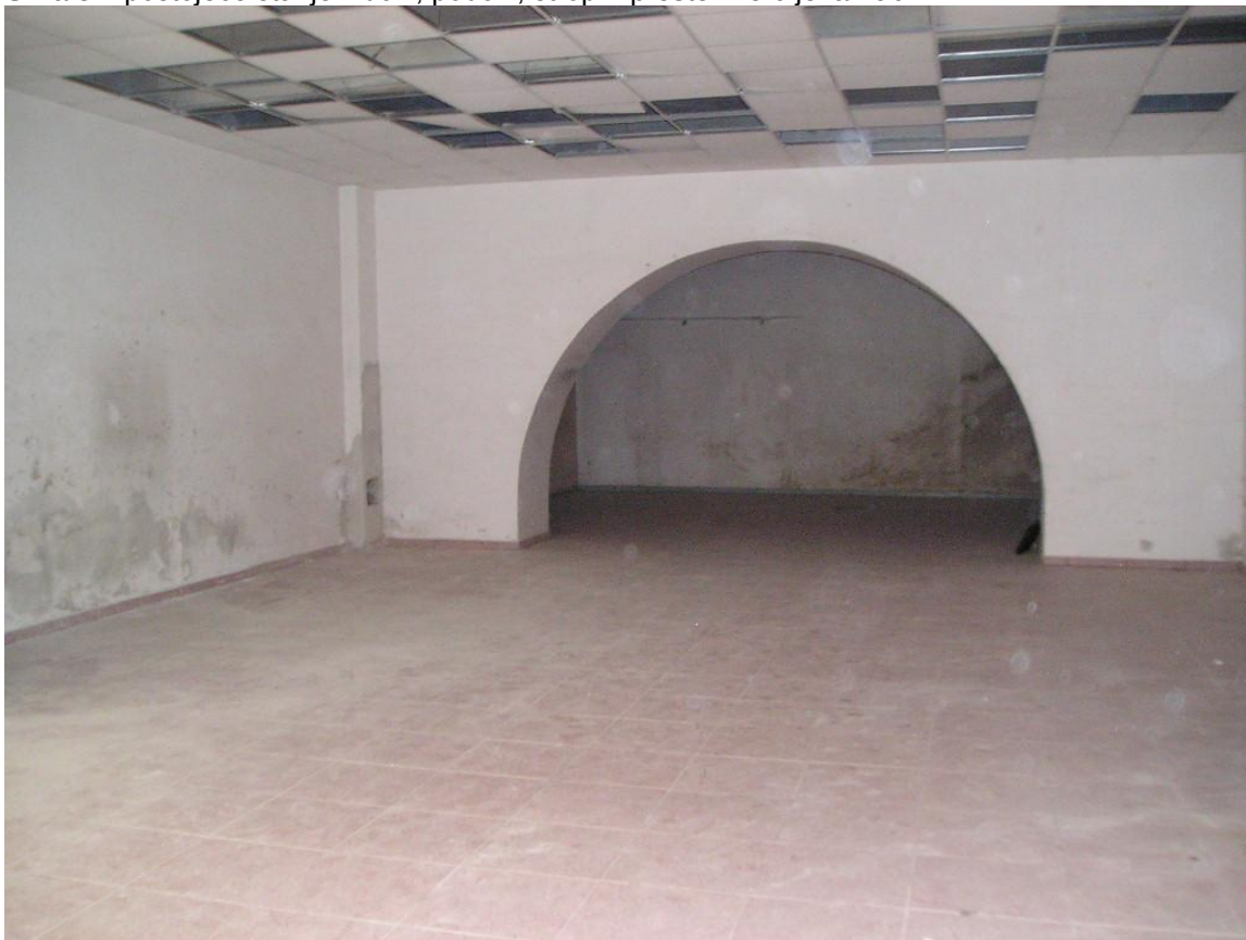
Slika 3 – postojeće stanje zidovi, podovi, strop – prostor Verdijeve 19b
