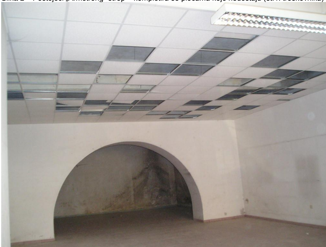
Slika 2 – Postojeći „Armstrong“ strop – kompletira se pločama koje nedostaju (st.1. troškovnika)
