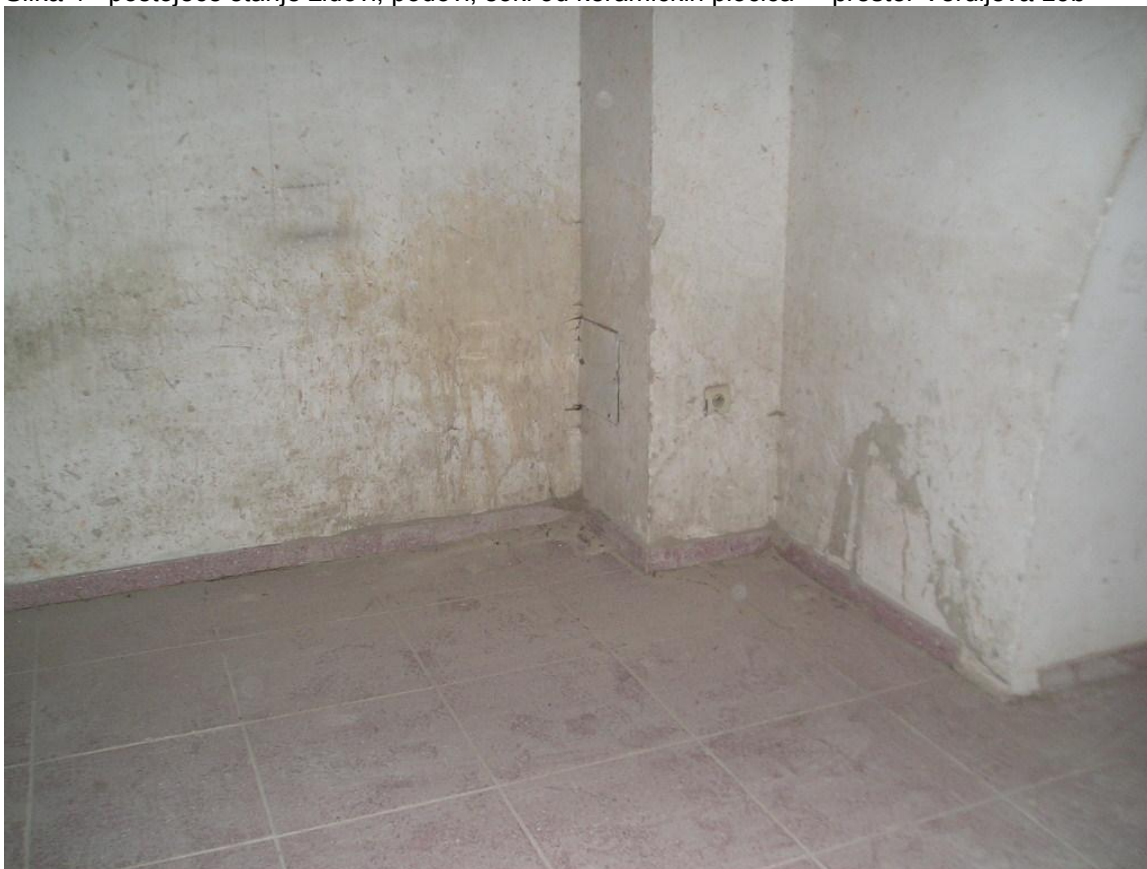
Slika 4 - postojeće stanje zidovi, podovi, sokl od keramičkih pločica – prostor Verdijeve 19b
