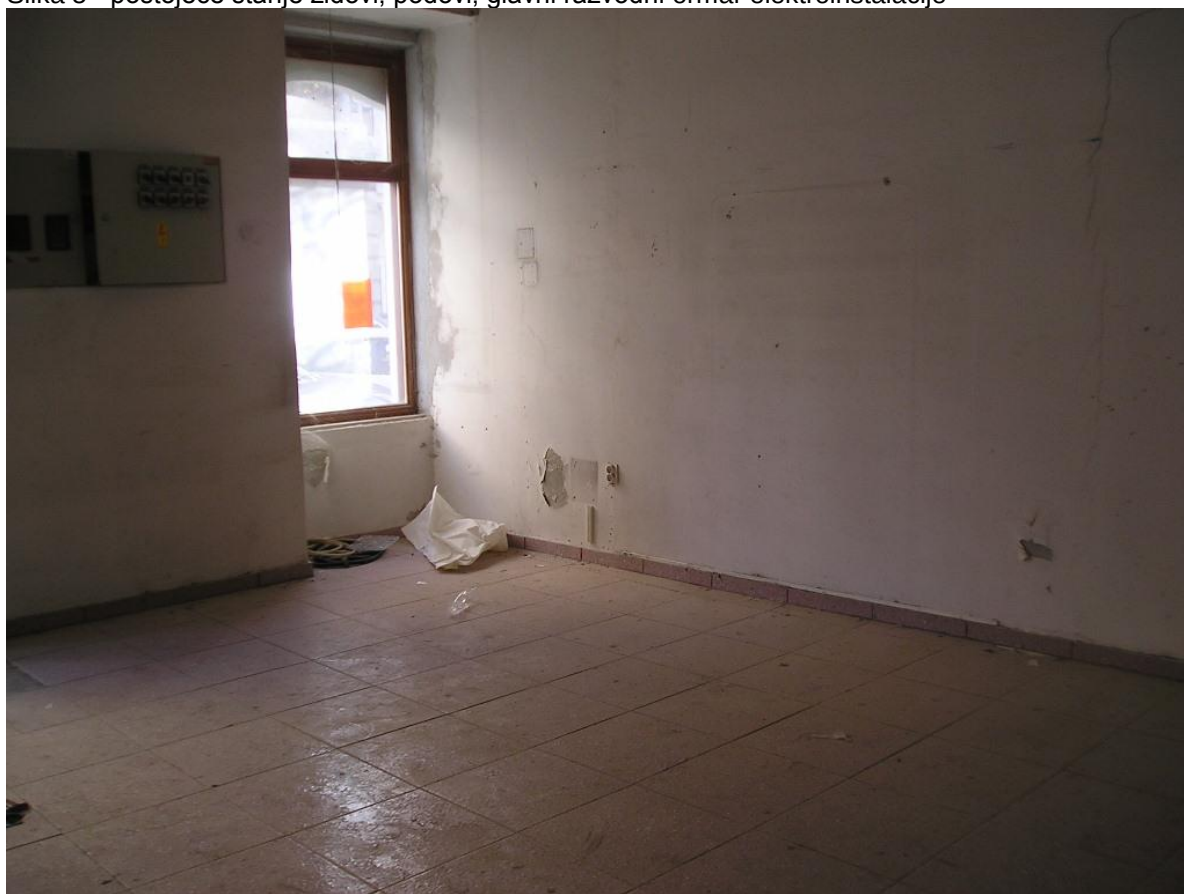
Slika 5 - postojeće stanje zidovi, podovi, glavni razvodni ormar elektroinstalacije
