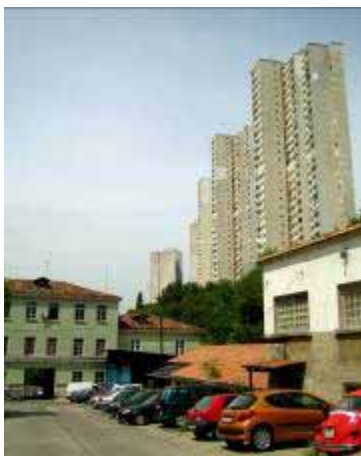
Fotografije postojećeg stanja
