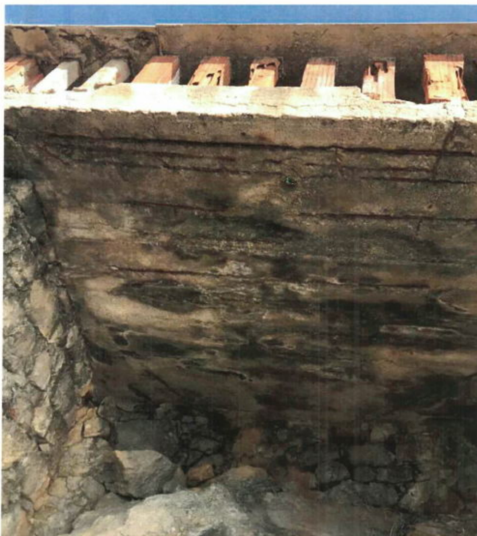
Slika 4. Korozija armature
