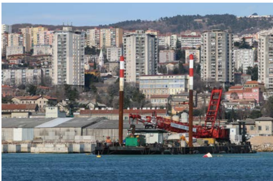
Radovi na Zapadnom lučkom terminalu
