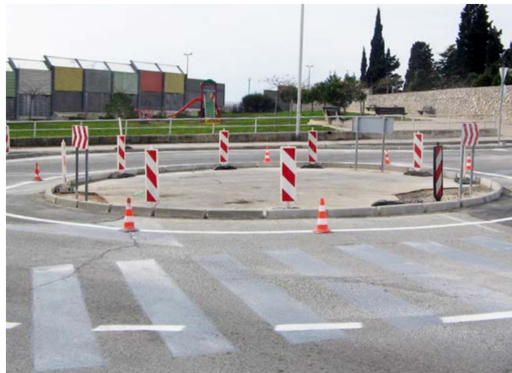
Izgradnja rotora na raskrižju Primorske i Ulice Vladivoja i Milivoja Lenca
