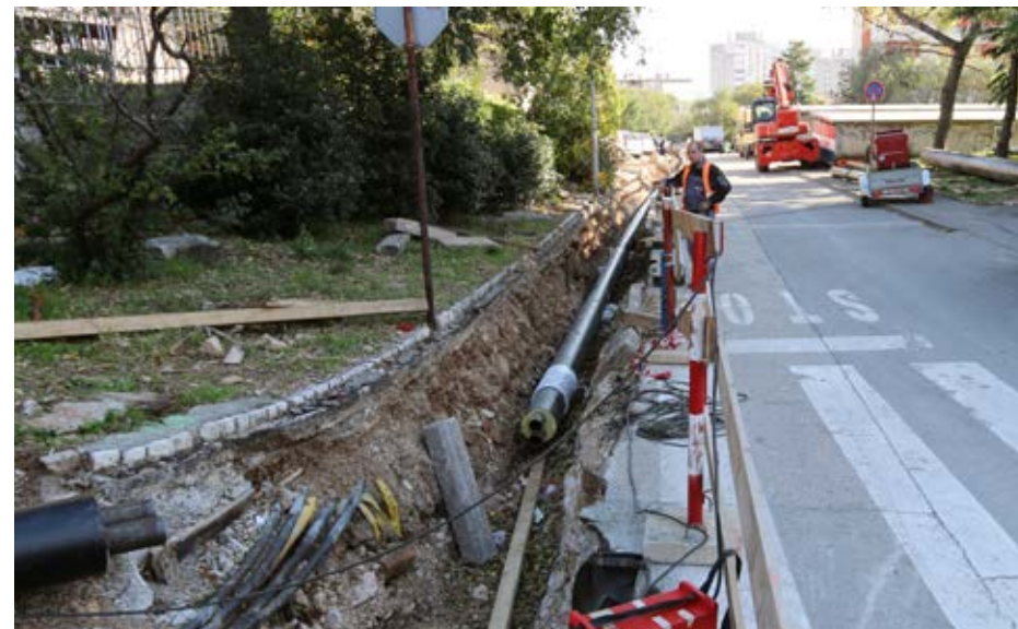
Gradnja toplovoda na Vojaku
