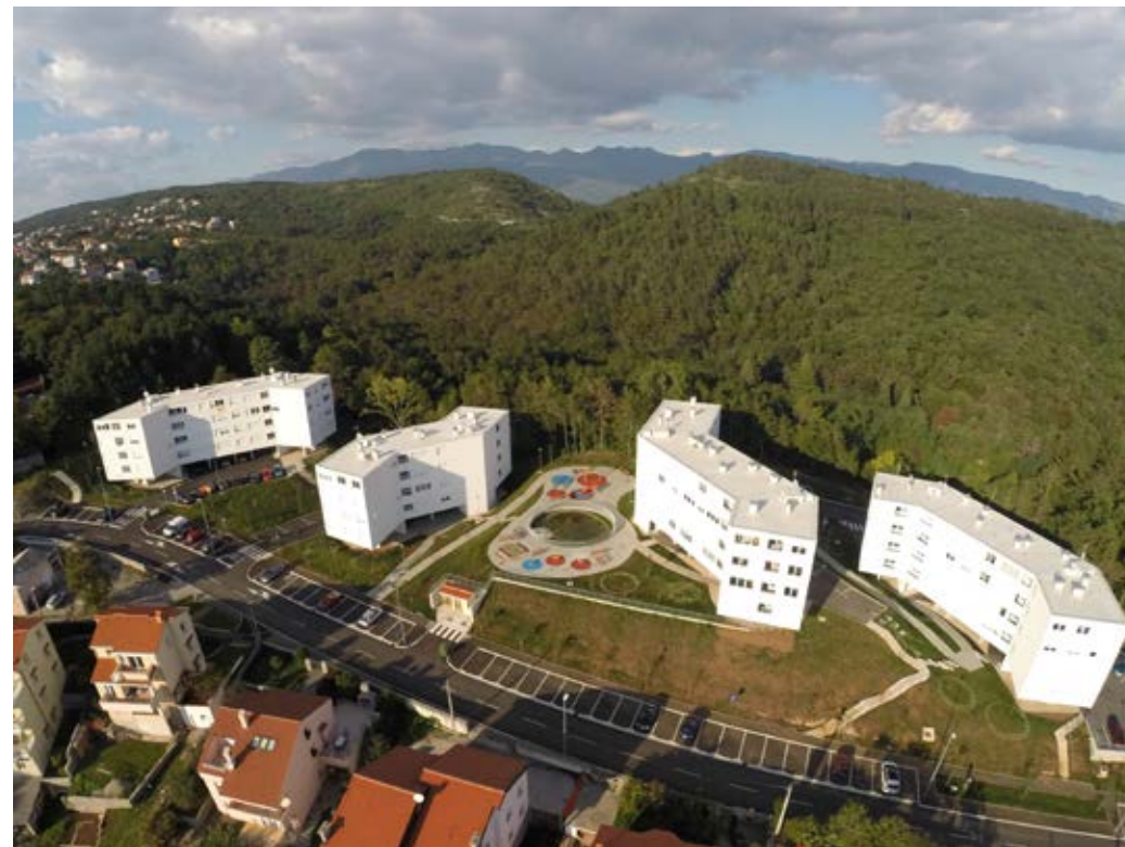
Na lokaciji Drenova u četiri objekta 80 stanova
