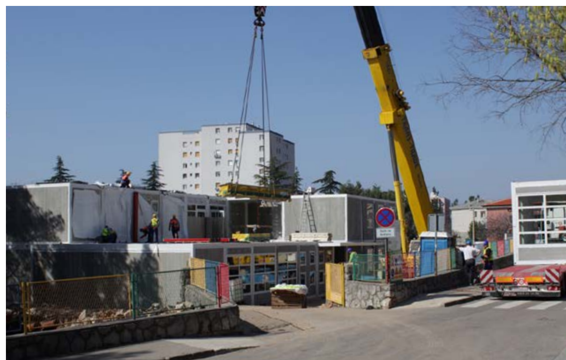
Radovi na Dječjem vrtiću Morčić
