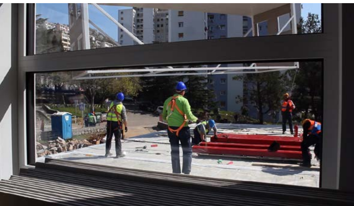
Gradilište Dječjeg vrtića Morčić
