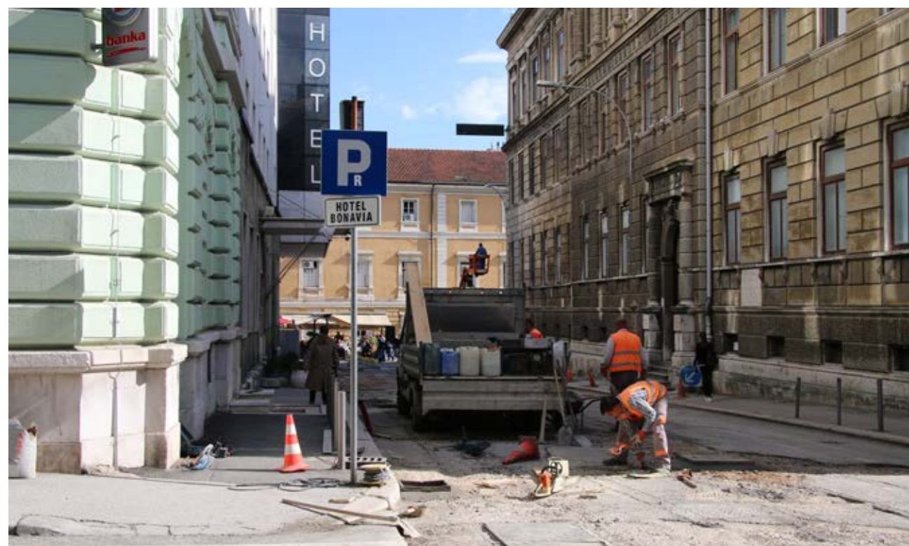
Radovi u Ulici Dolac
