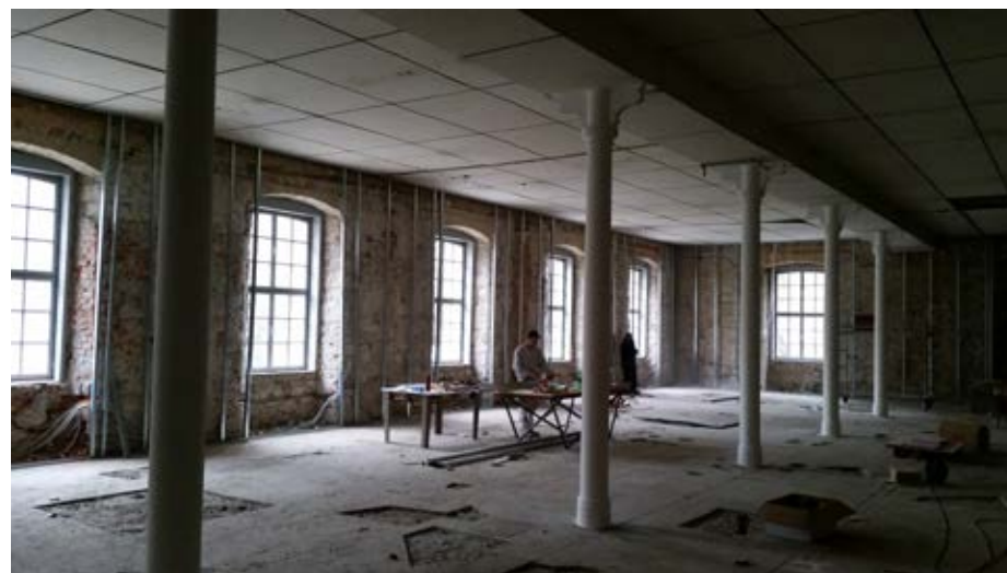
Kompleks Benčić - H-objekt, radovi na rekonstrukciji za smještaj MMSU-a
