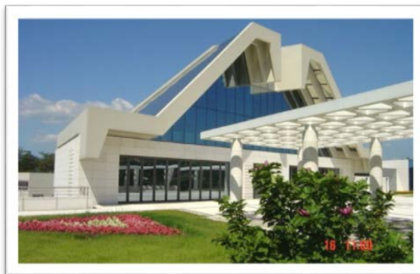
Slika 26: Centralni objekt na CGG Drenova
