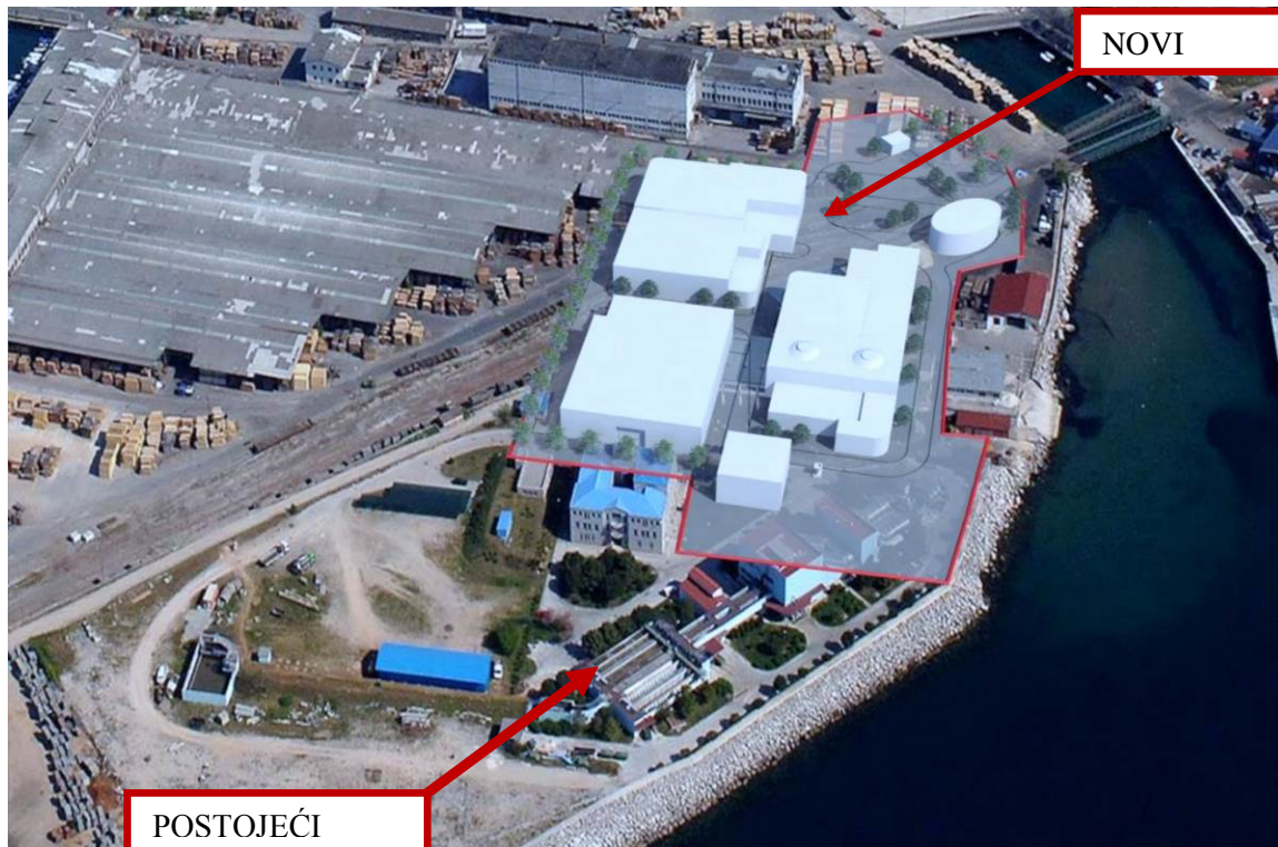
Slika 7: Novi uređaj za pročišćavanje otpadnih voda aglomeracije Rijeka
