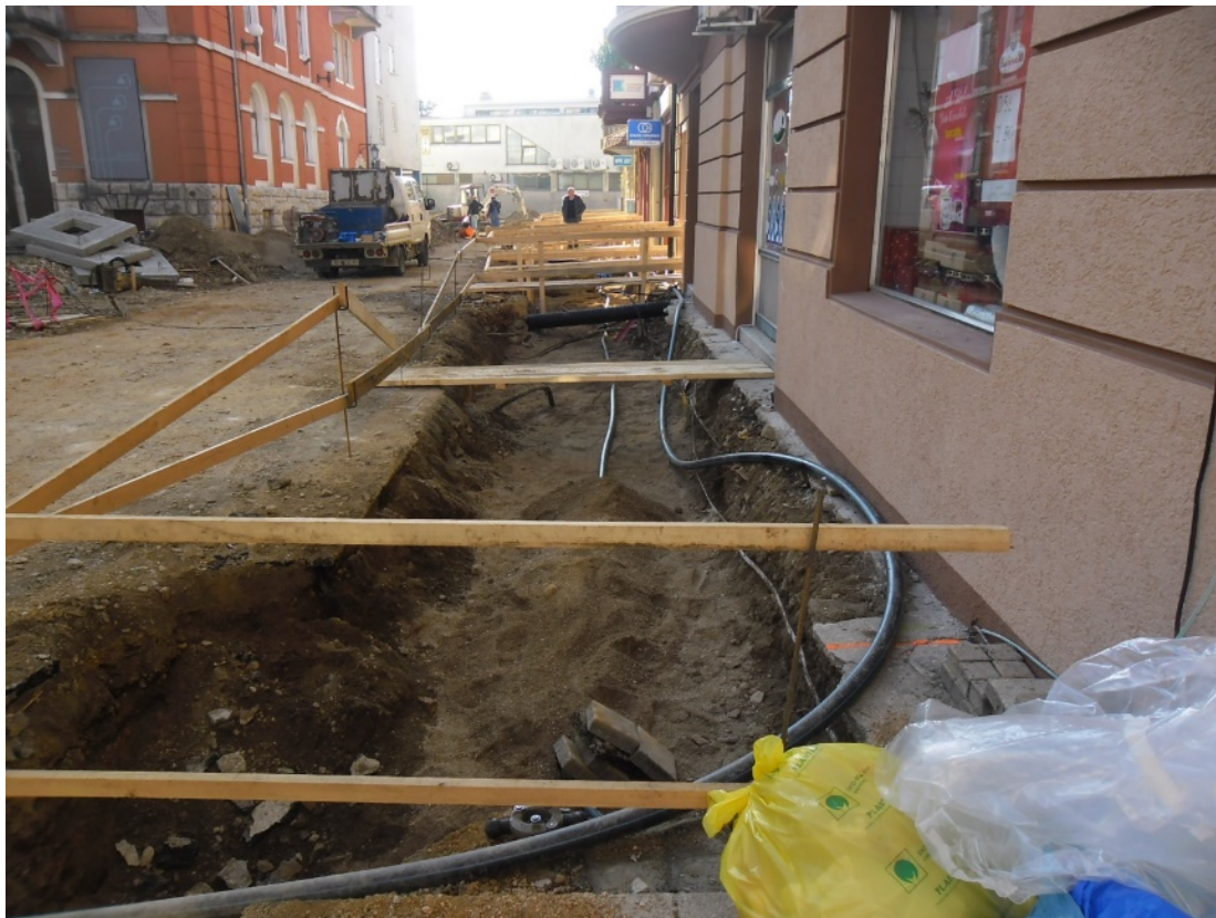
Slika 18: Izgradnja plinovoda na području grada Crikvenice – Preradovićeva ulica
