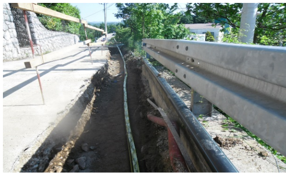
Slika 13: Rekonstrukcija plinovoda na području općine Viškovo
