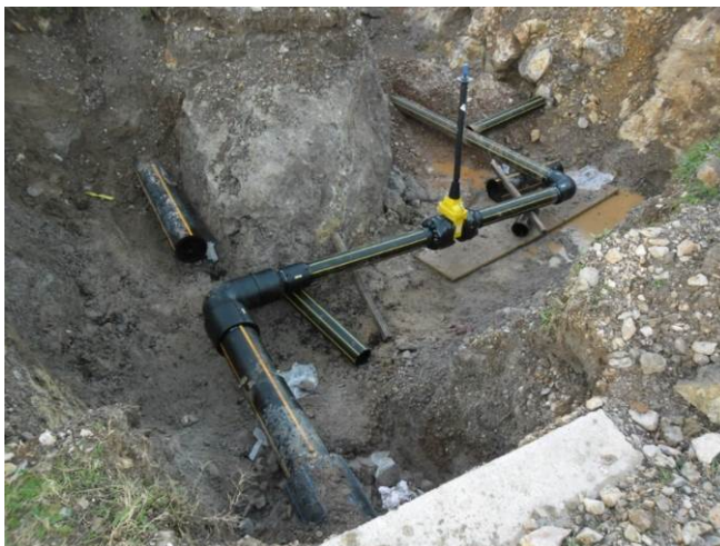
Slika 15: Rekonstrukcija plinovoda na području općine Klana - Marišćina
