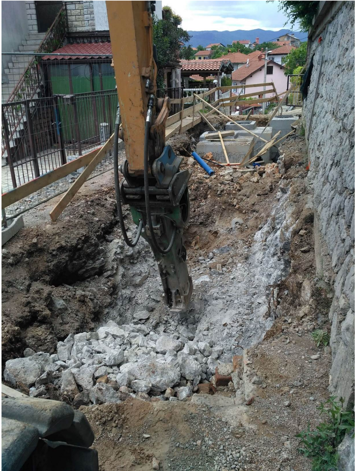
Slika 9: Tijekom izvođenja radova Gornji Zamet – Z1
