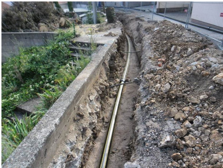
Slika 16: Rekonstrukcija plinovoda na području općine Kostrena - Glavani
