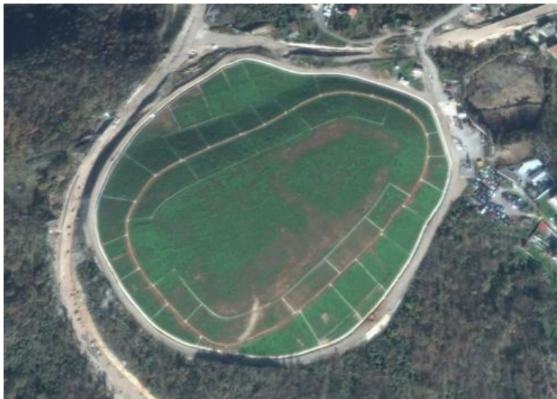
Slika 1: Sanirano odlagalište neopasnog otpada Viševac
