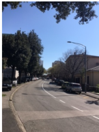
Slika 20: Rekonstrukcija javne rasvjete u Baštijanovoj ulici
