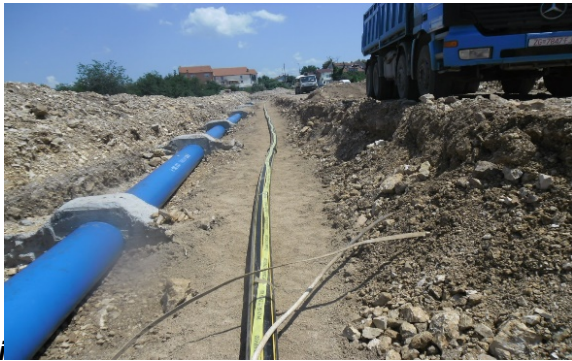
Slika 13: Rekonstrukcija plinovoda na području općine Viškovo
