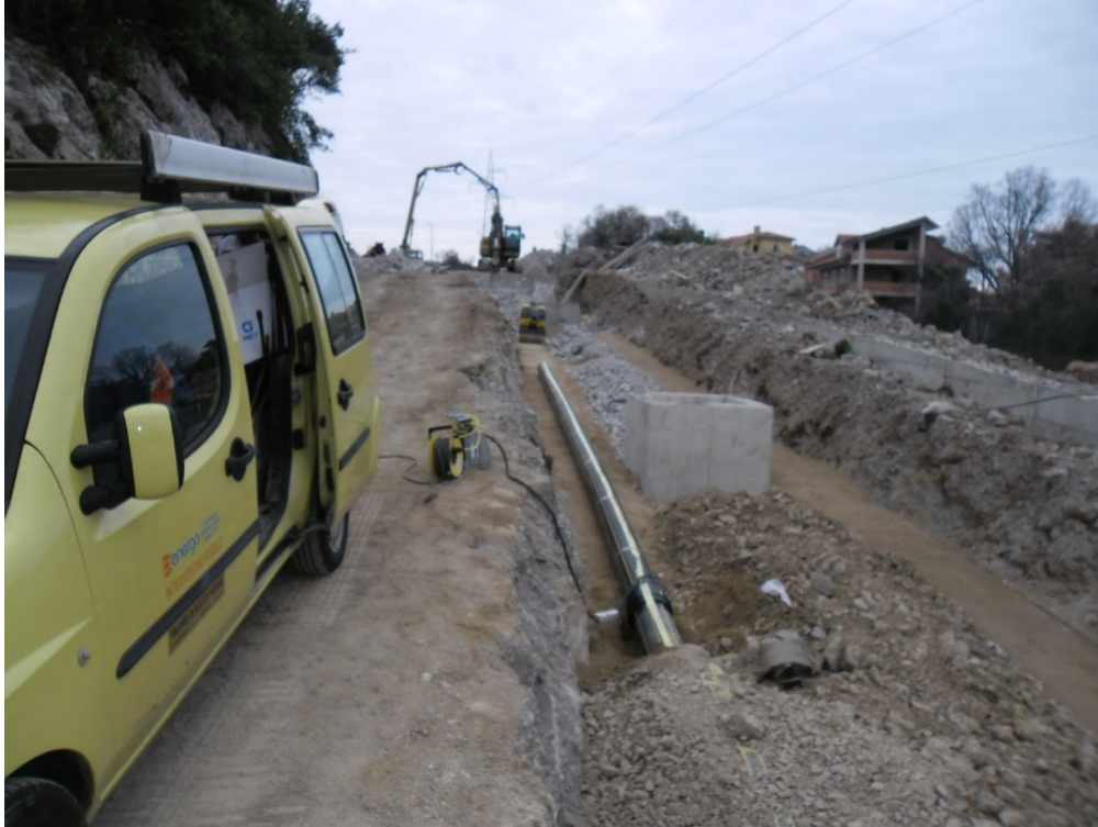
Slika 14: Izgradnja plinovoda na području grada Kastva – rotor Belići prema dvorani
