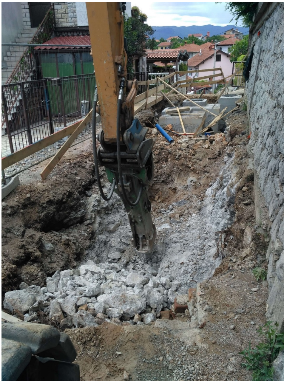
Slika 4: Tijekom izvođenja radova Gornji Zamet – Z1
