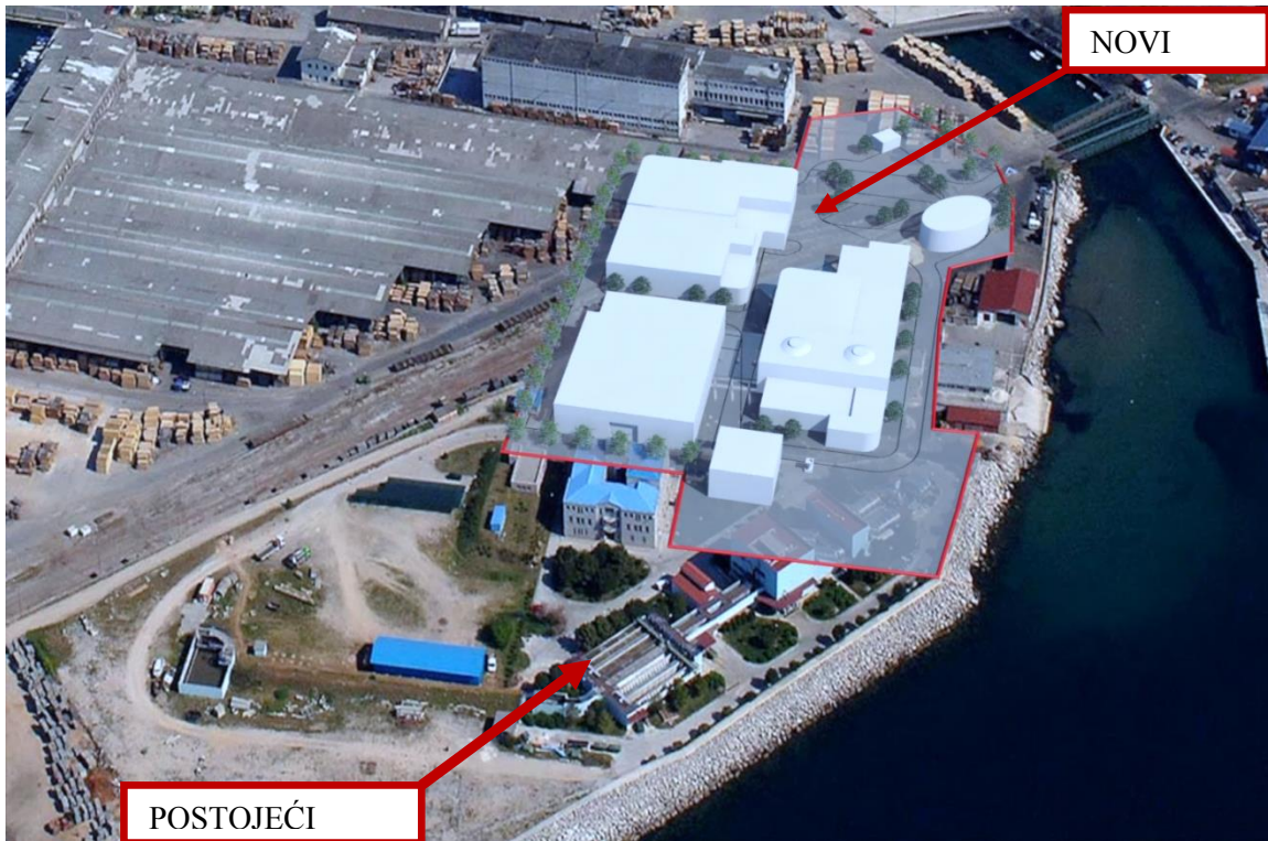
Slika 2: Novi uređaj za pročišćavanje otpadnih voda aglomeracije Rijeka
