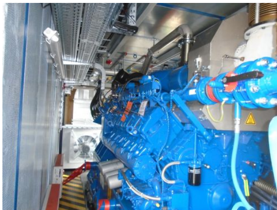
Postrojenje za proizvodnju električne energije iz odlagališnog plina
