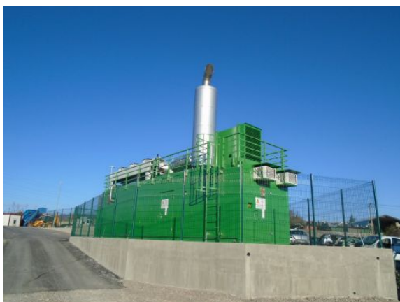
Postrojenje za proizvodnju električne energije iz odlagališnog plina
