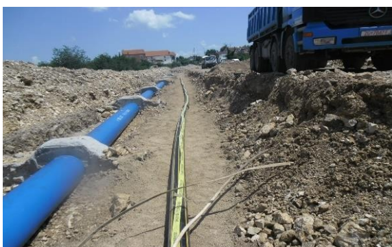
Slika 7: Rekonstrukcija plinovoda na području općine Viškovo
