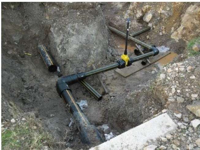
Slika 9: Rekonstrukcija plinovoda na području općine Klana - Marišćina
