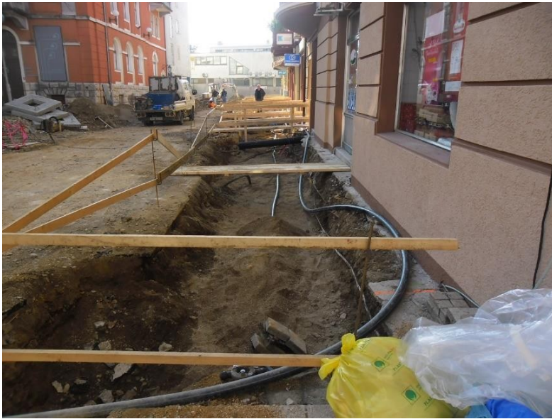
Slika 12: Izgradnja plinovoda na području grada Crikvenice – Preradovićeve ulica
