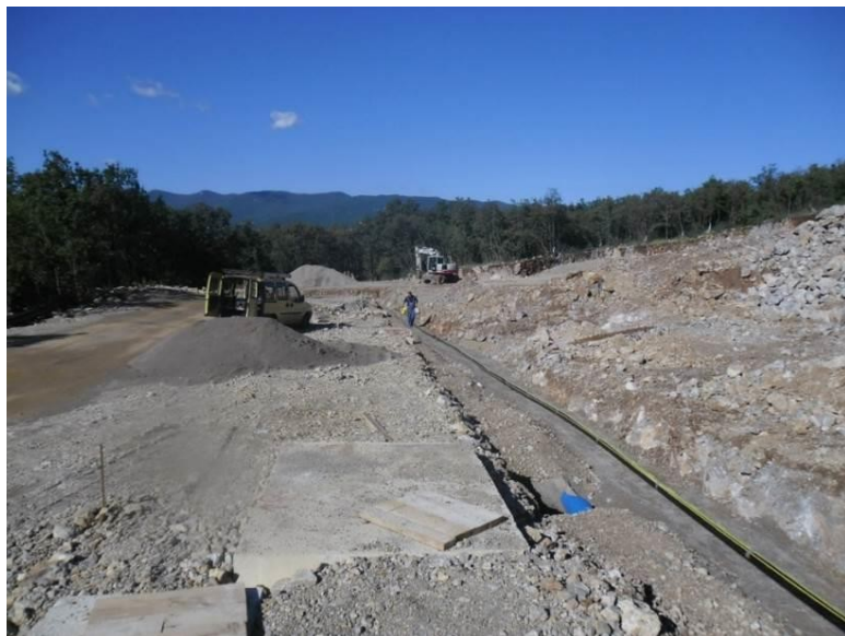
Slika 6: Izgradnja plinovoda na području grada Rijeke – Martinkovac
