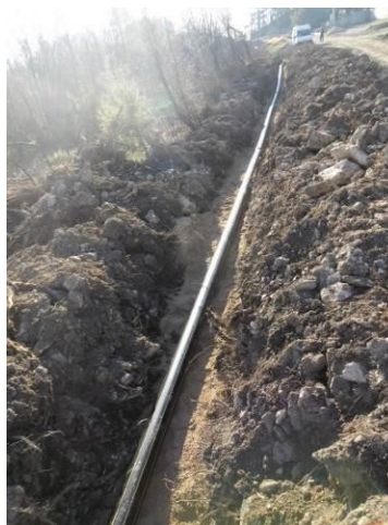
Slika 9: Rekonstrukcija plinovoda na području općine Klana - Marišćina
