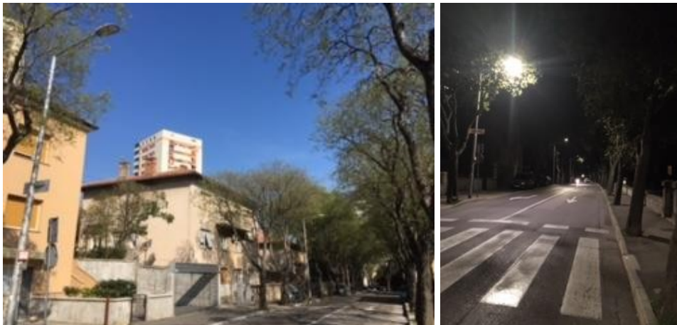
Slika 13: Rekonstrukcija javne rasvjete u Mihanovićevoj ulici
