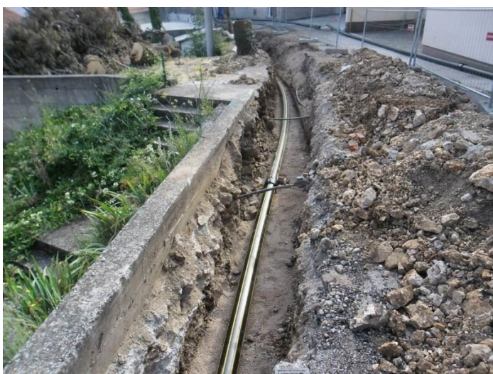
Slika 10: Rekonstrukcija plinovoda na području općine Kostrena - Glavani
