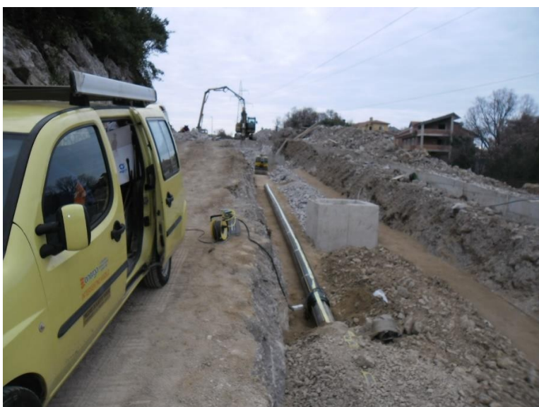
Slika 8: Izgradnja plinovoda na području grada Kastva – rotor Belići prema dvorani
