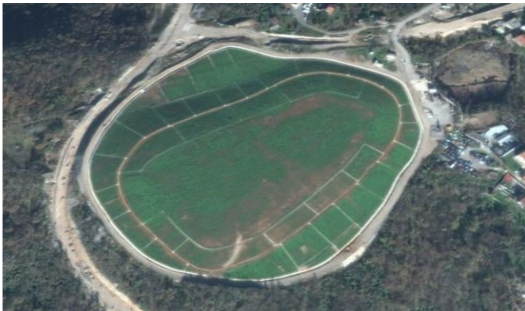
Sanirano odlagalište otpada Viševac,
