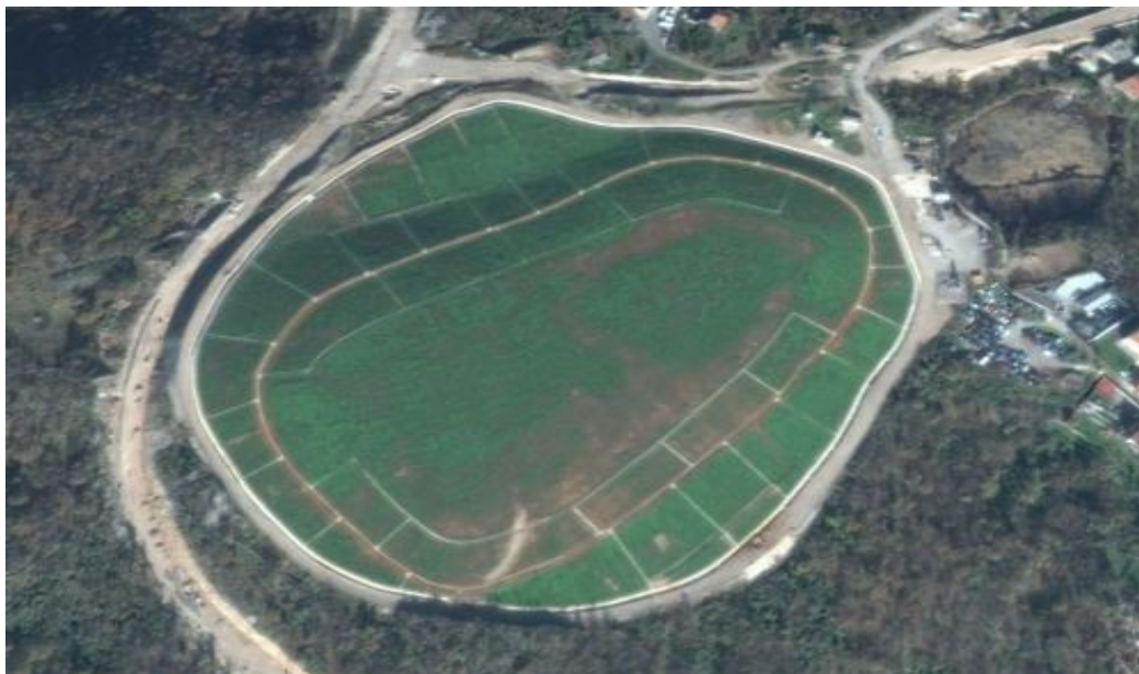
Sanirano odlagalište otpada Viševac
