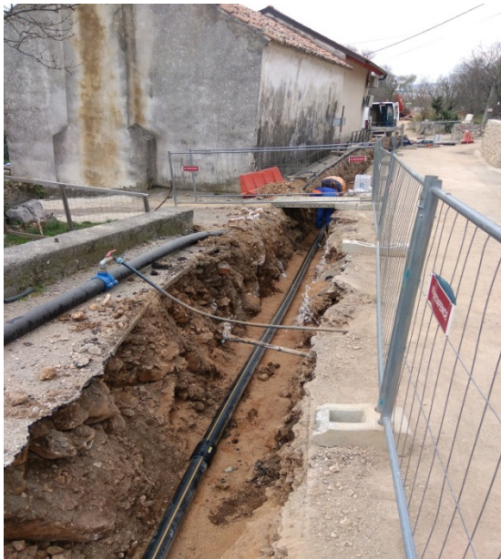
Slika 15: Rekonstrukcija plinovoda na području općine Kostrena - Mažeri
