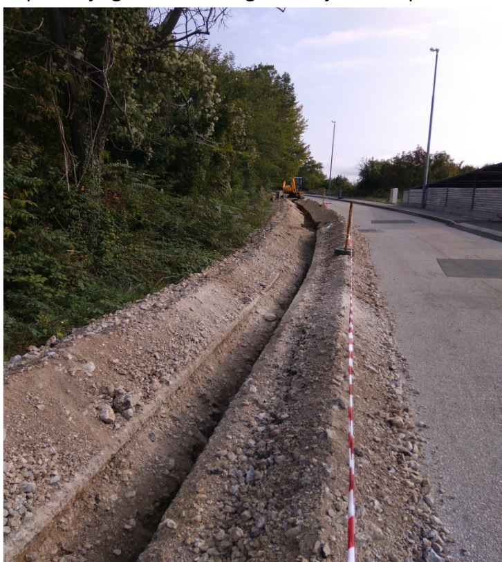
Slika 14: Izgradnja plinovoda na području grada Kastva – Rešetari
