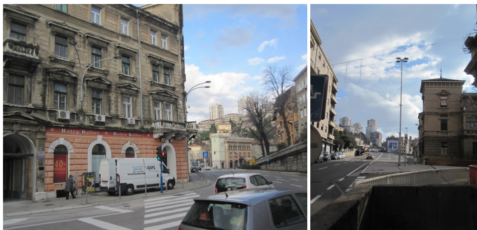
Slika 19: Rekonstrukcija javne rasvjete dijela Strossmayerove ulice
