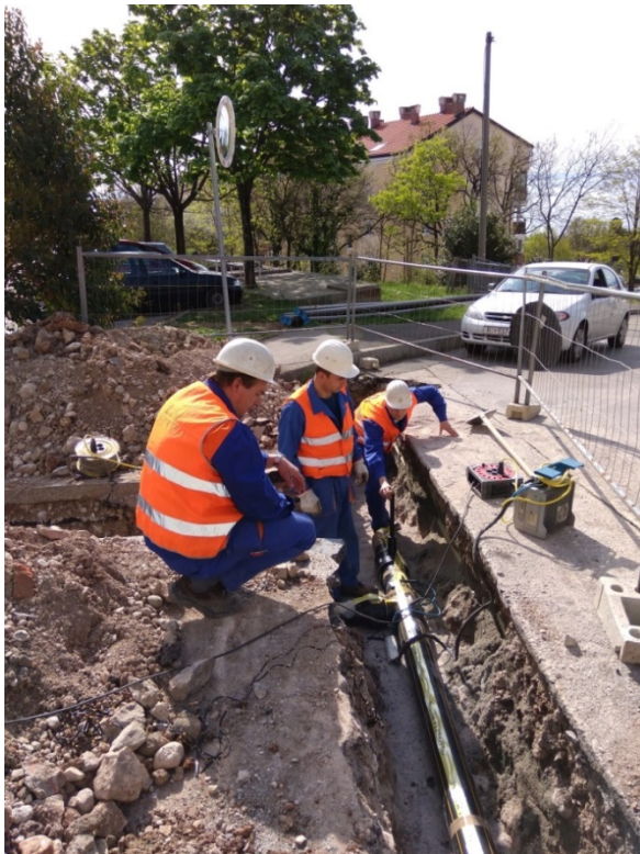
Slika 12: Izgradnja plinovoda na području grada Rijeke – Tina Ujevića
