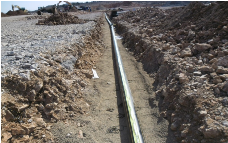
Slika 16: Izgradnja plinovoda na području grada Bakra– Kukuljanovo SEKTOR JAVNA RASVJETA
