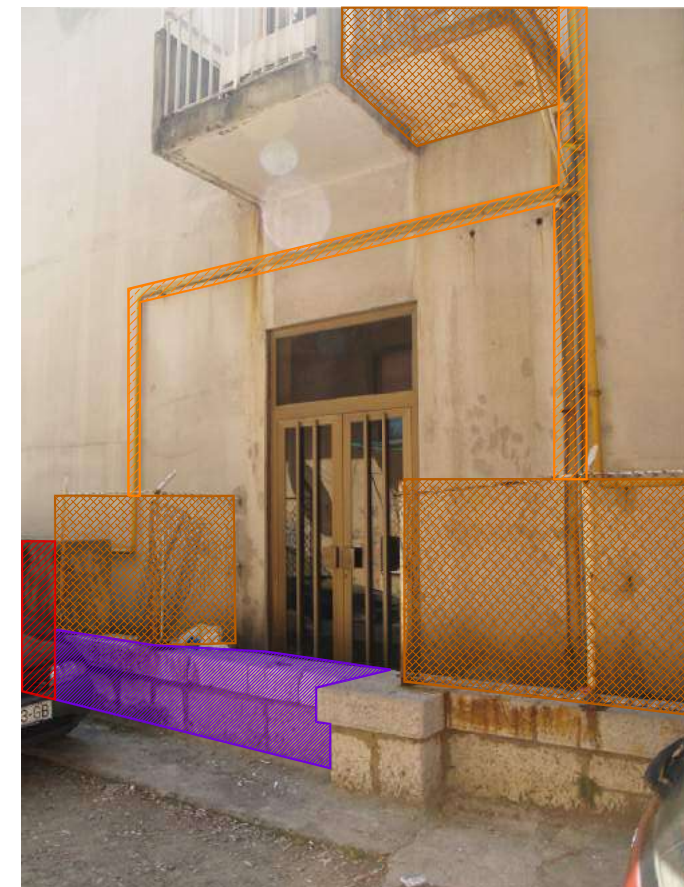
Slika 5 - Sjeverno pročelje-stražnji ulaz
