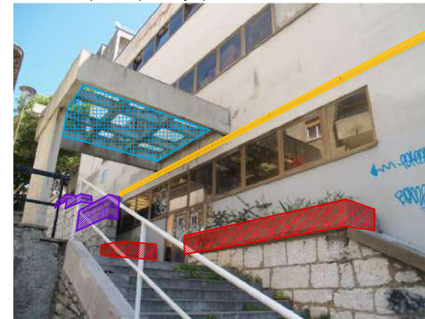
Slika 7 - Zapadno pročelje-bočni ulaz
