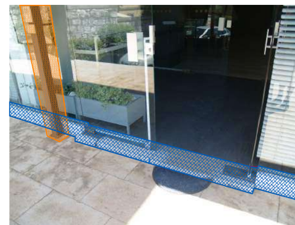
Slika 5 - Južno pročelje-glavni ulaz
