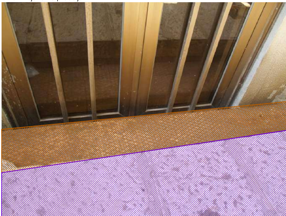
Slika 2 - Sjeverno pročelje-stražnji ulaz
