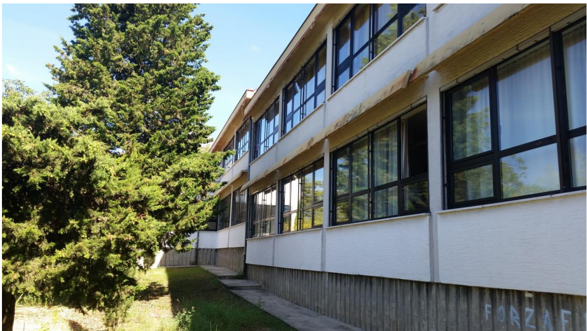
Sl.5. Jugozapadno pročelje
