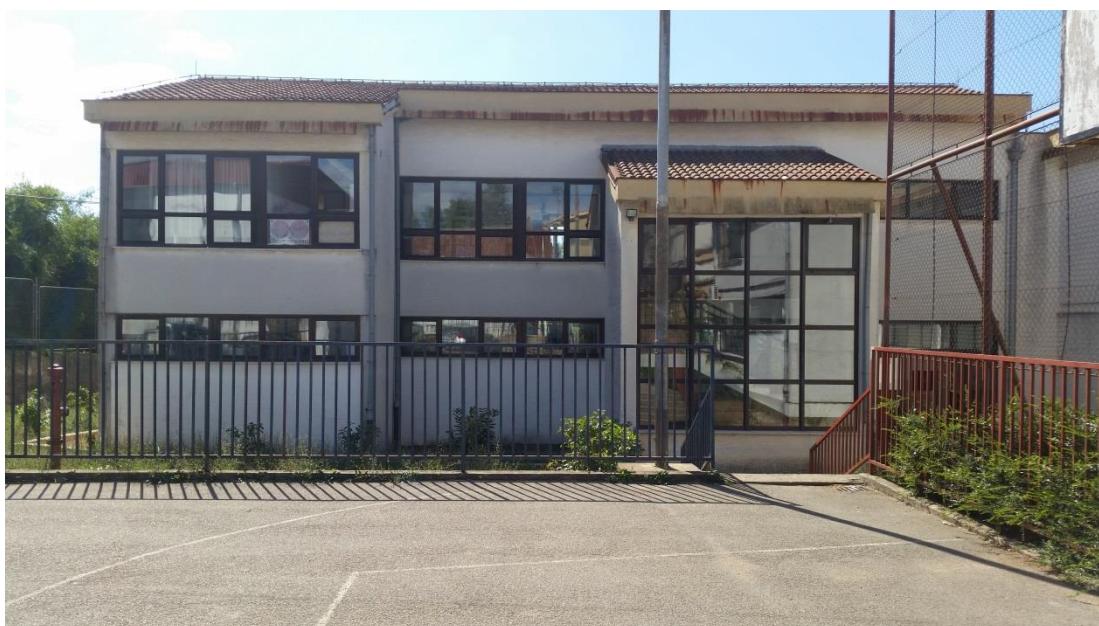
Sl.8. Sjeverozapadno pročelje
