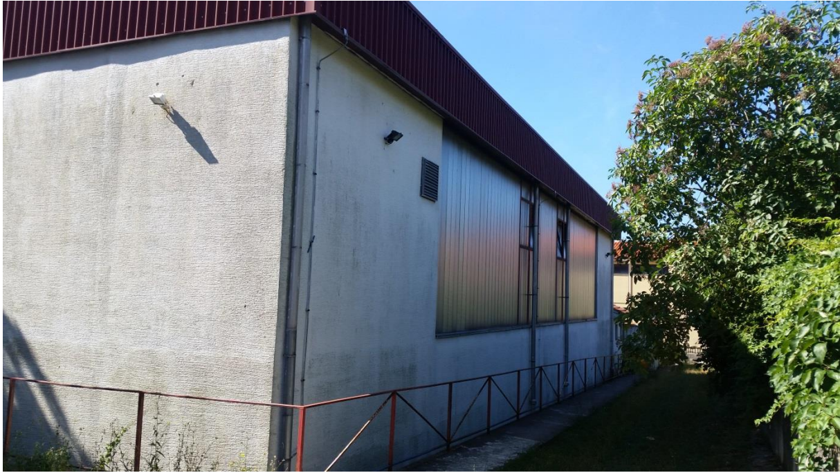
Sl.14. Sjeverozapadno pročelje dvorane
