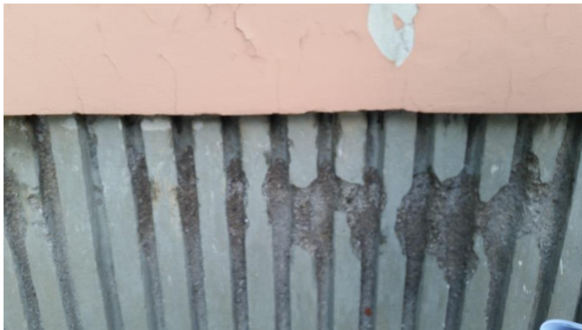
Sl.15. Betonske kanelure
