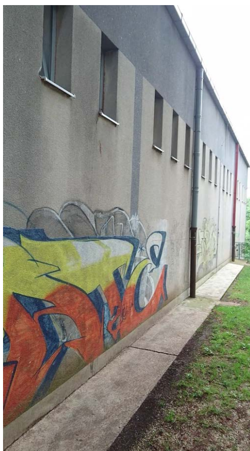
Dvorana - Sjeverno pročelje
