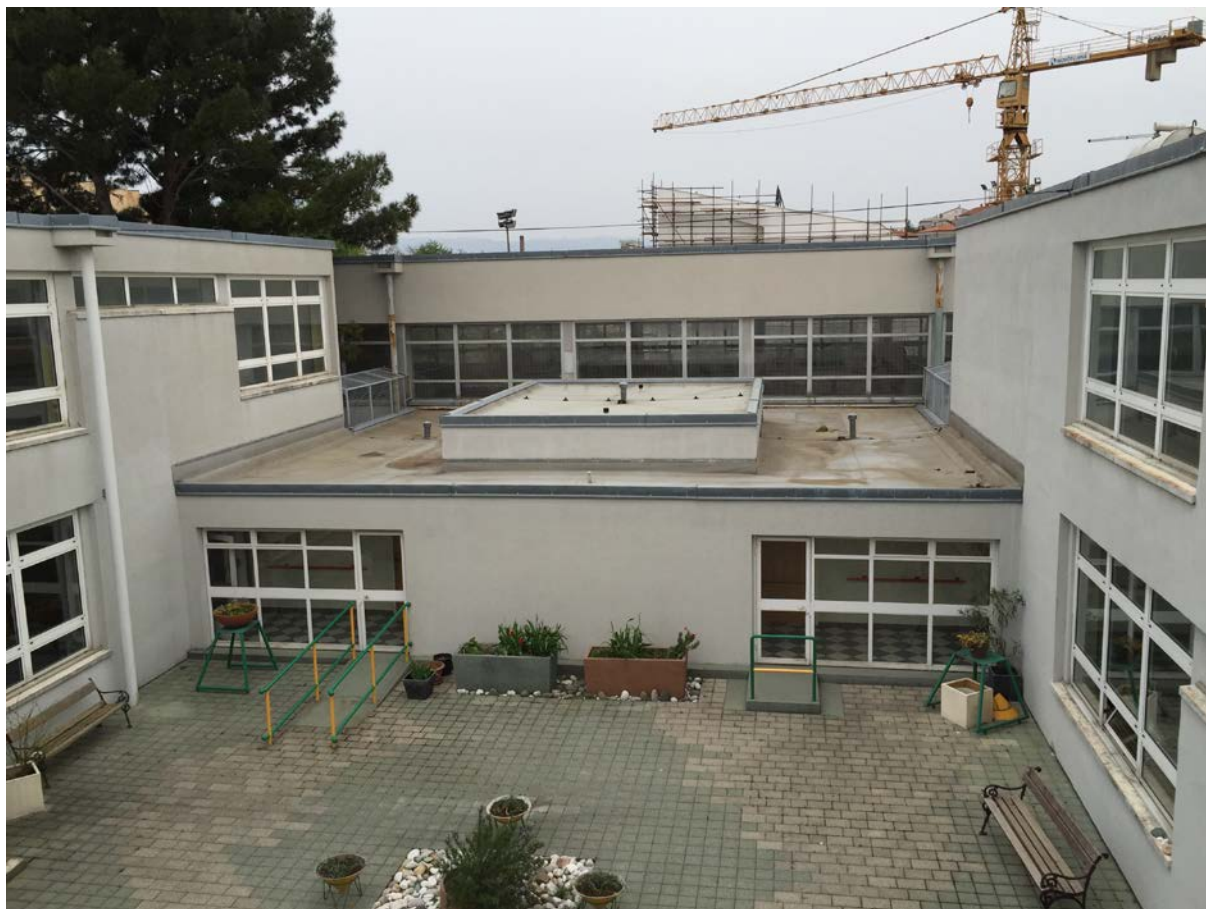
Jugoistočno pročelje (JI 1, JI2, JI 3)
