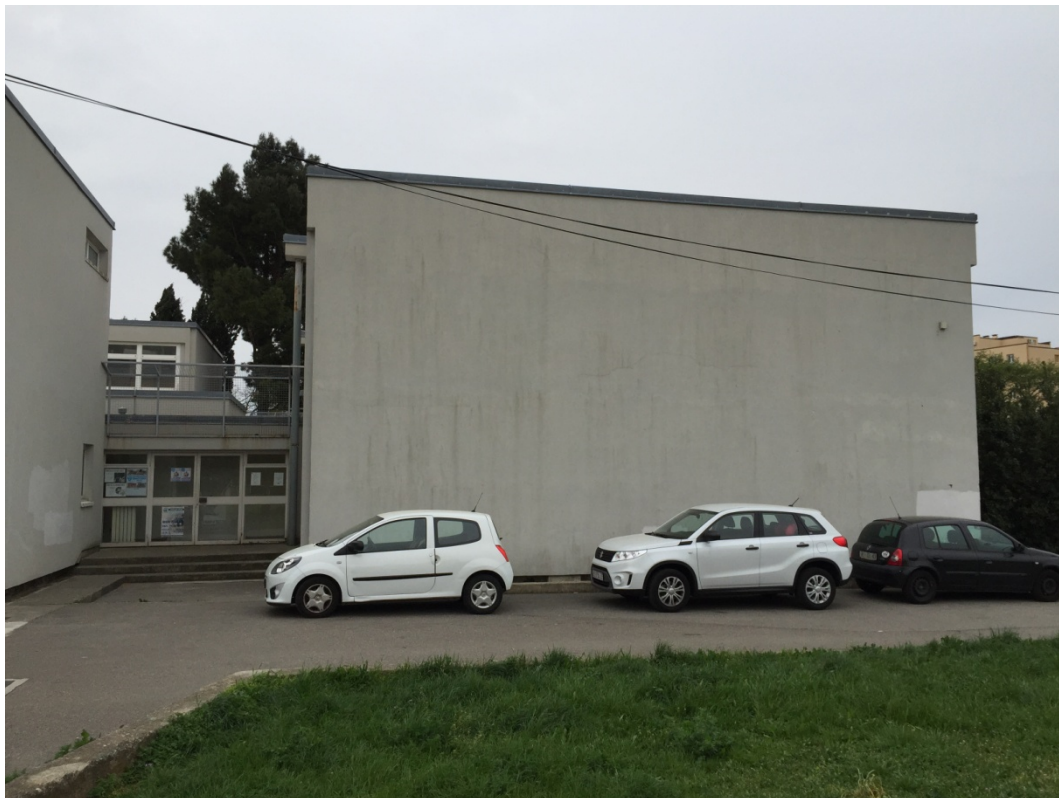
Sjeveroistočno pročelje (SI 1)
