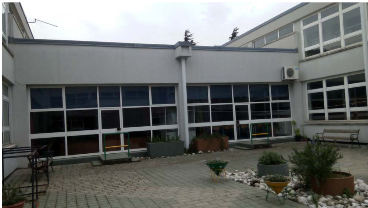
Sjeverozapadno pročelje (SZ 3)
