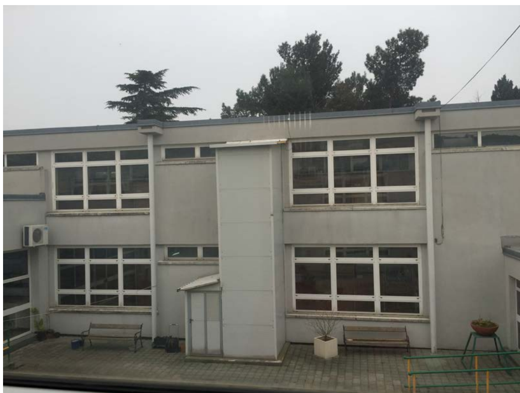
Sjeveroistočno pročelje (SI 2)
