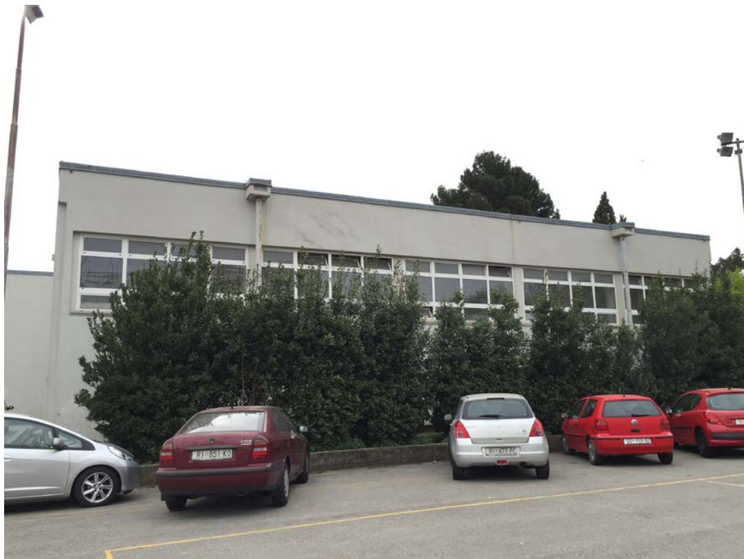
Sjeverozapadno pročelje (SZ 1)
