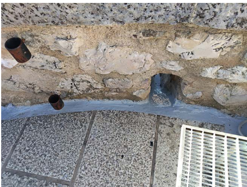
Hidroizolacijska traka koju uje potrebno ukloniti
