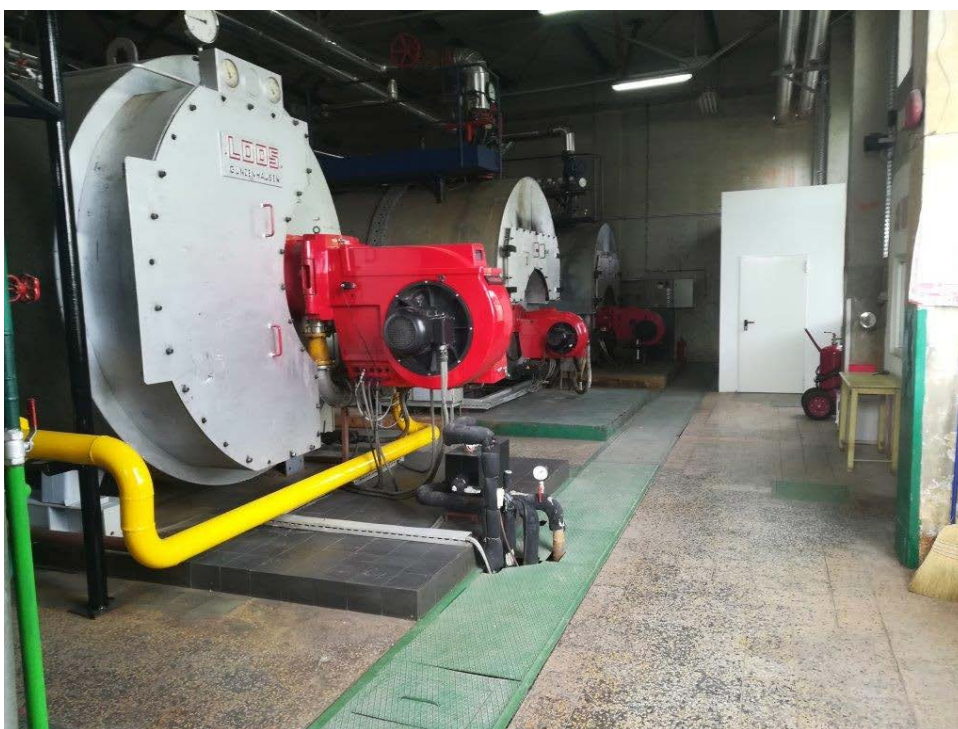
Slika 12: Izvedeni radovi – Plinifikacija glavnog kotla na toplani Vojak
