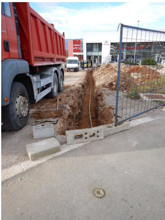
Slika 16: Izgradnja plinovoda na području općine Viškovo - Furićevo
