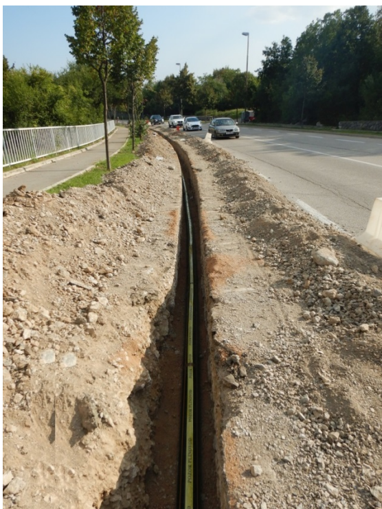
Slika 17: Izgradnja plinovoda na području grada Kastva – dionica Rešetari - Jurčići
