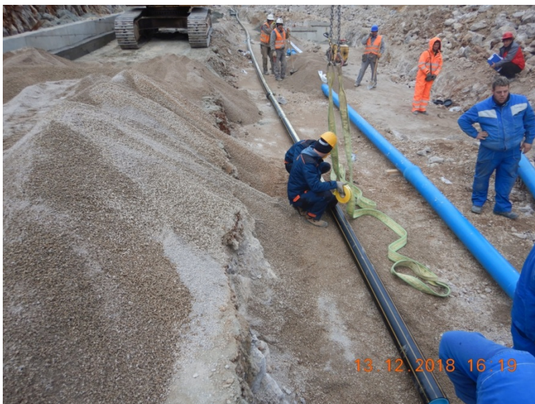
Slika 15: Izgradnja plinovoda na području grada Rijeke – Martinkovac OU10A
