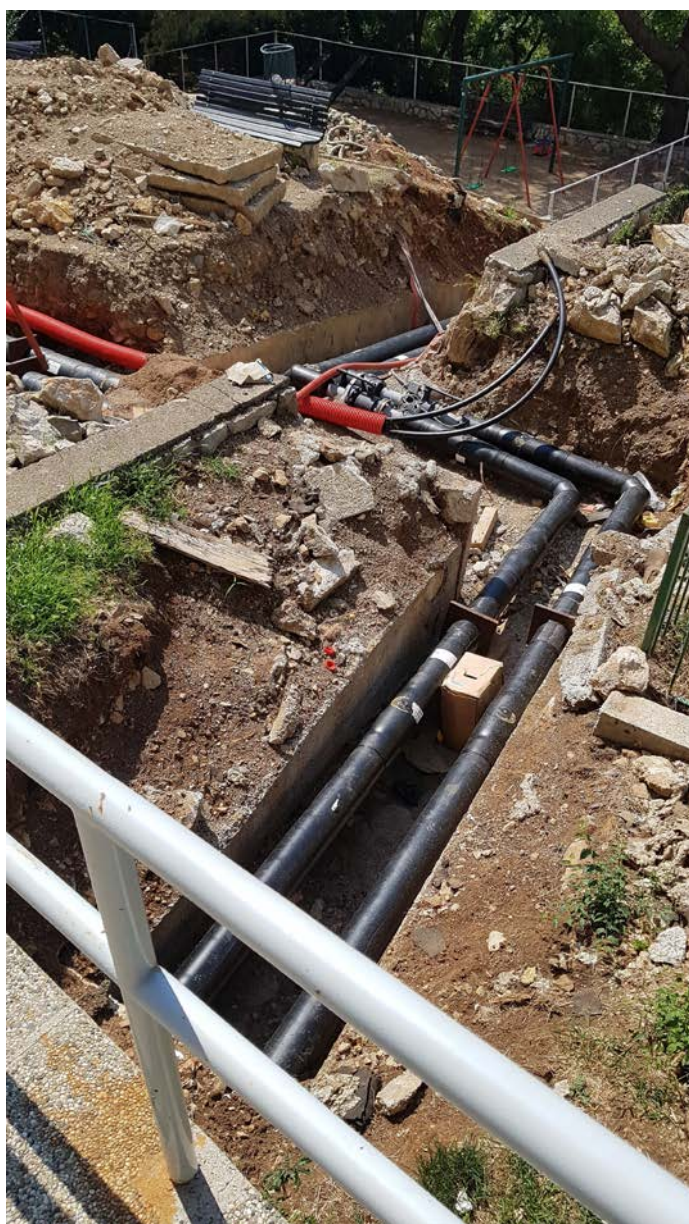
Slika 11: Izvedeni radovi – sustav Skurinja
