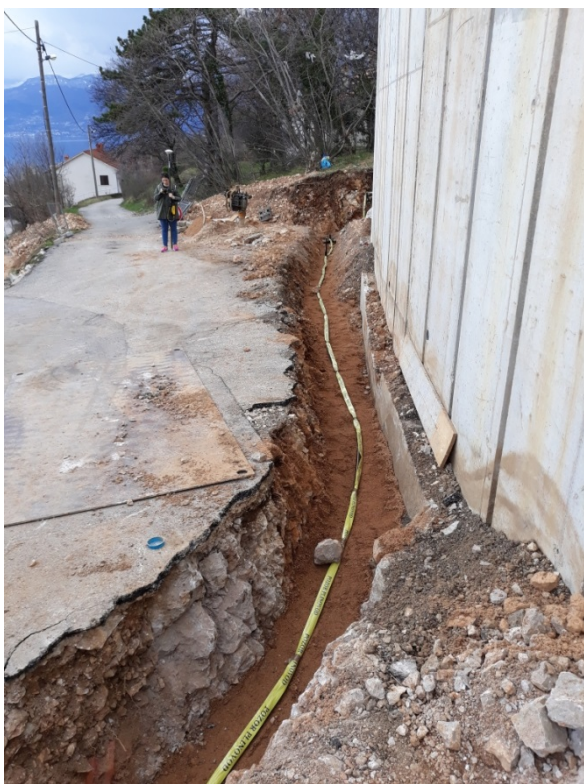
Slika 14: Izgradnja plinovoda na području grada Rijeke – Bok/Drenova
