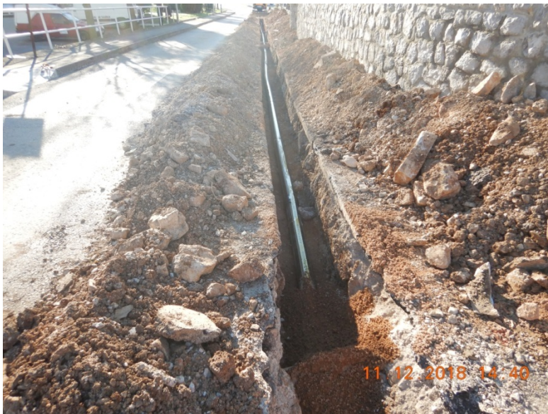
Slika 13: Izgradnja plinovoda na području grada Rijeke – A.B.Šimića/Srdoči
