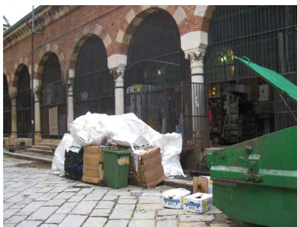
Istočno pročelje zgrade ribarnice ne zaslužuje ovakav izgled
