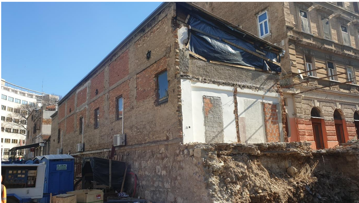
Sjeverozapadno i jugozapadno pročelje
