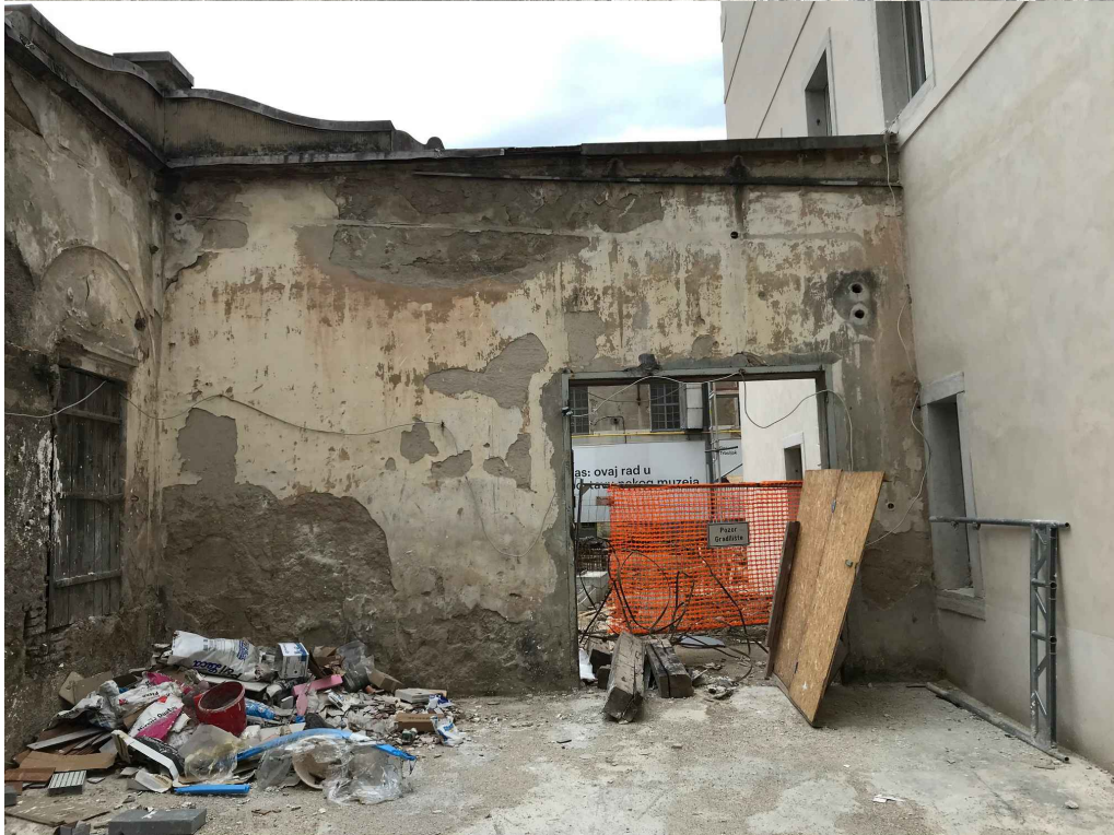
SPOJNI ZID POGLED SA ZAPADA
